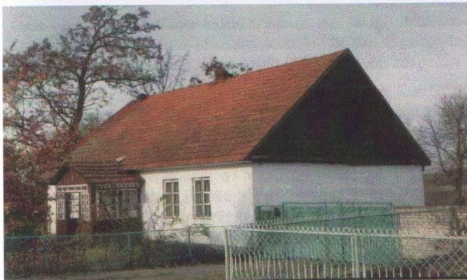
Fot. 38. Sędowice. Przykład budownictwa wiejskiego; zabytek kultury
