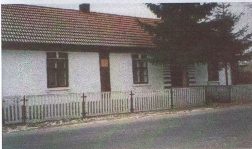
Fot. 30, 31, 32. Zagajów – budownictwo ludowe; budynki w dobrym i bardzo dobrym stanie technicznym – zabytki kultury
