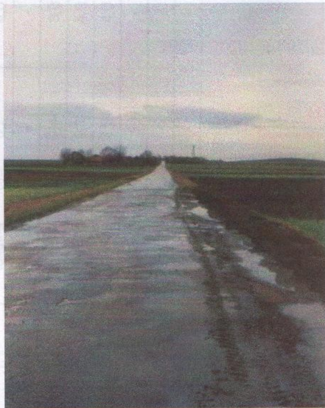
Fot. 45. Fragment drogi gminnej 1541015; w oddali widoczne zabudowania Tura Dolnego
