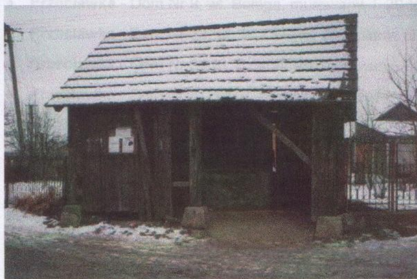
Fot. 30. Przecławka – obudowa studni
