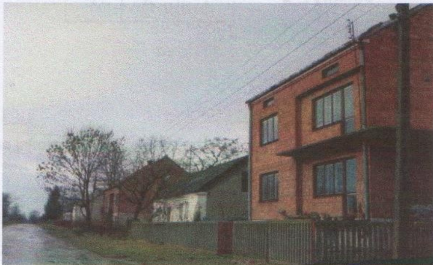
Fot. 14. Tur Górny. Piętrowe budynki najprawdopodobniej w przyszłości będą zastępować niską zabudowę.
