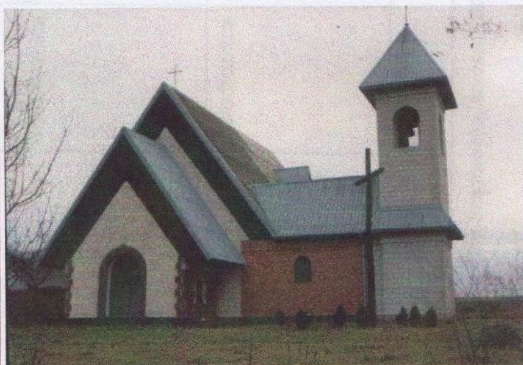
Fot. 21. Kościół w Turze Dolnym
