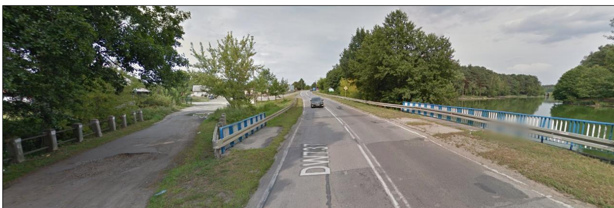
Fot. 16 Przejście drogi wojewódzkiej DW737 przez Gzówkę (po prawej stronie widoczny Zalew w Siczkach) [112]
