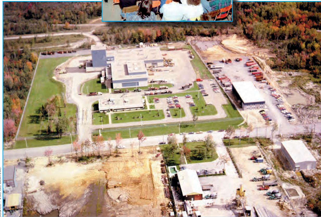
Vue aérienne de l'usine Stablex Canada, en mars 1988.
