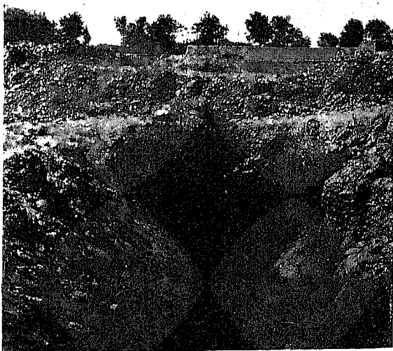
Кяризы въ Закаспійской области. Выходъ подземной галлерей на поверхность.
