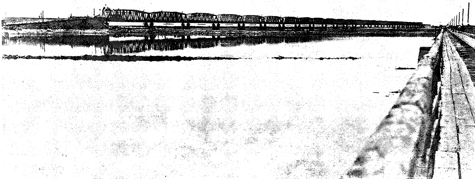
Чарджуйскій желъзнодорожный мостъ (длина 800 саж.), справа временный мостъ.
