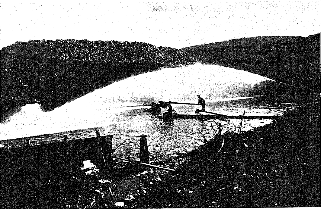
Гидравлическій способъ разработки розсыпей.
