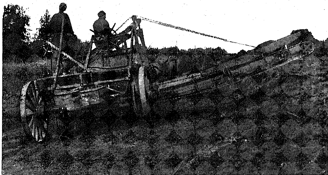
Производство земляныхъ работъ экскаваторами при постройкѣ Сибирской жел. дор.
