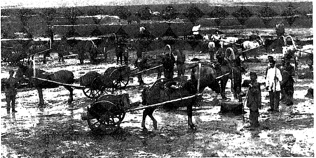
Снятие торфовъ—слоевъ, покрывающихъ золотоносный пластъ (Забайкальская обл.).
