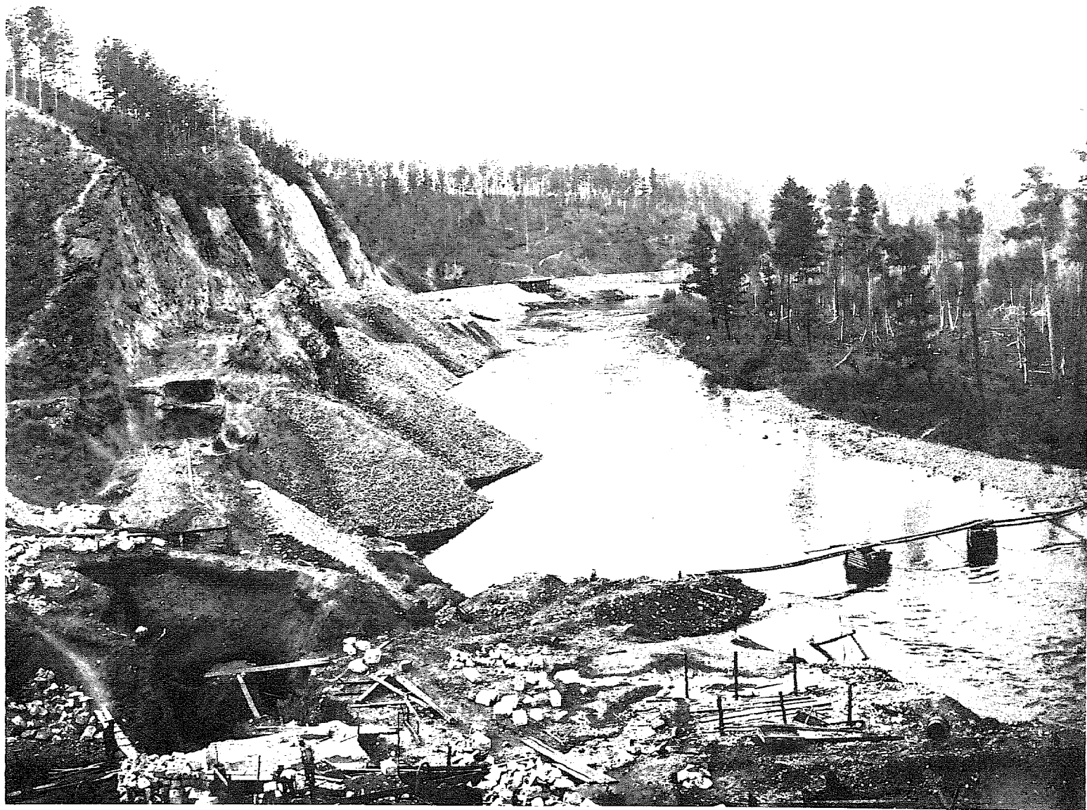
Постройка железнодорожного полотна по косогору на 32-й верстѣ Западнаго участка Амурской жел. дор. близь рѣки Черной.
