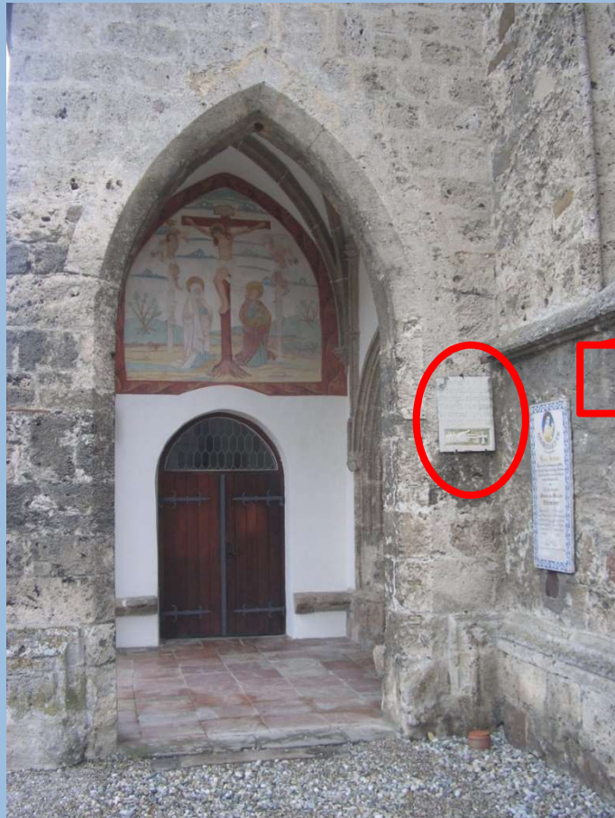
Position der Hochwassermarke 2006 (Foto: Christian Rohr)
