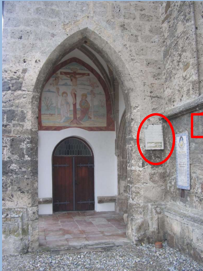
Position der Hochwassermarke 2006 (Foto: Christian Rohr)
