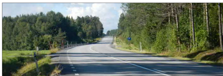
Figur 50. Dagens utseende på fotot söder om avtagsväg mot Gumboda hamn jämfört med fotot nedan av en 2+1 väg med mitträcke, sidoräcke och viltstängsel dvs blivande utseende för E4.
