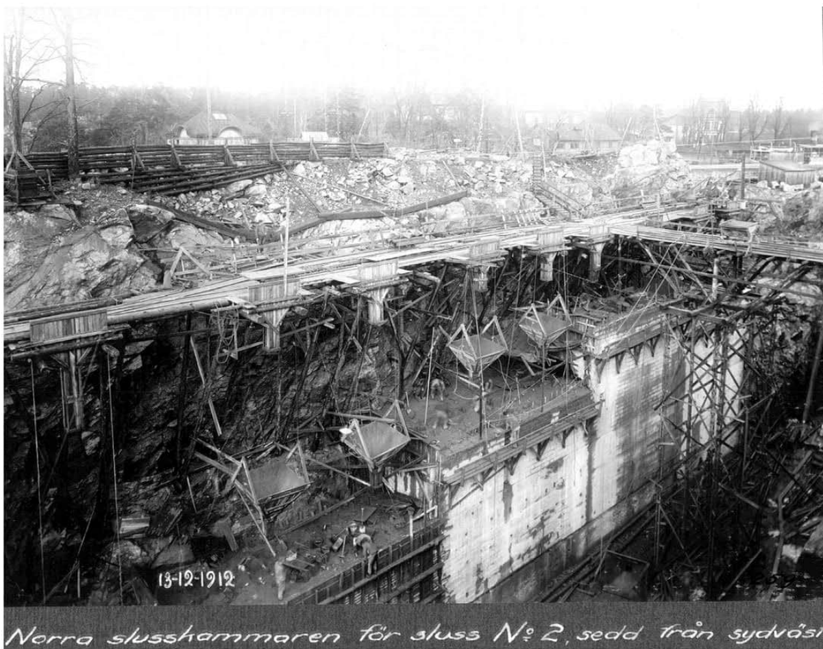
Foto 1. Byggnation av 1916 års sluss
