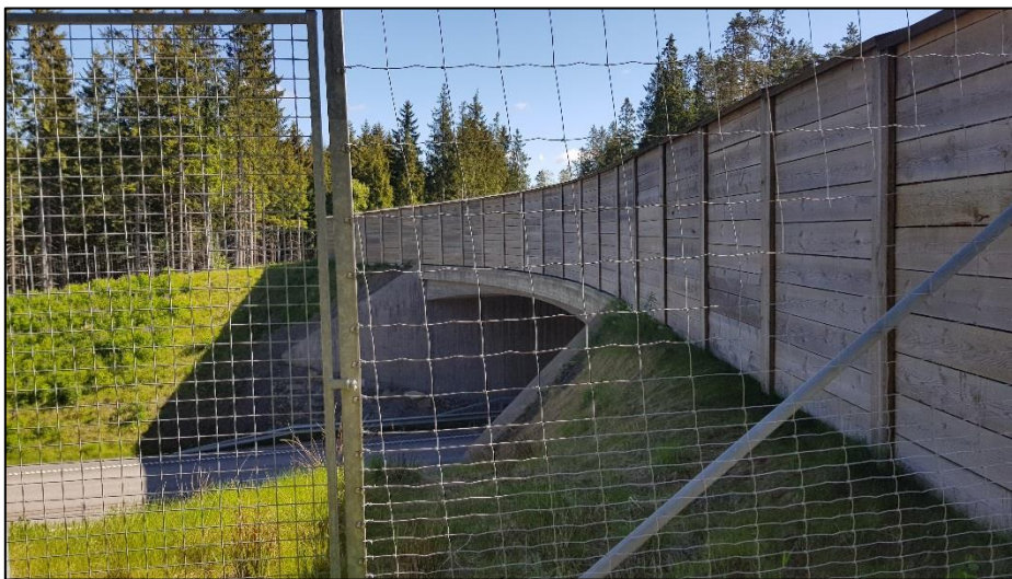
Exempel på faunabro där bländskyddet dragits ned över betongkonstruktionen.
