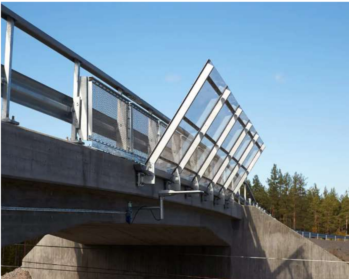
Figur 5.1-3. Exempel på elskyddsskärm
