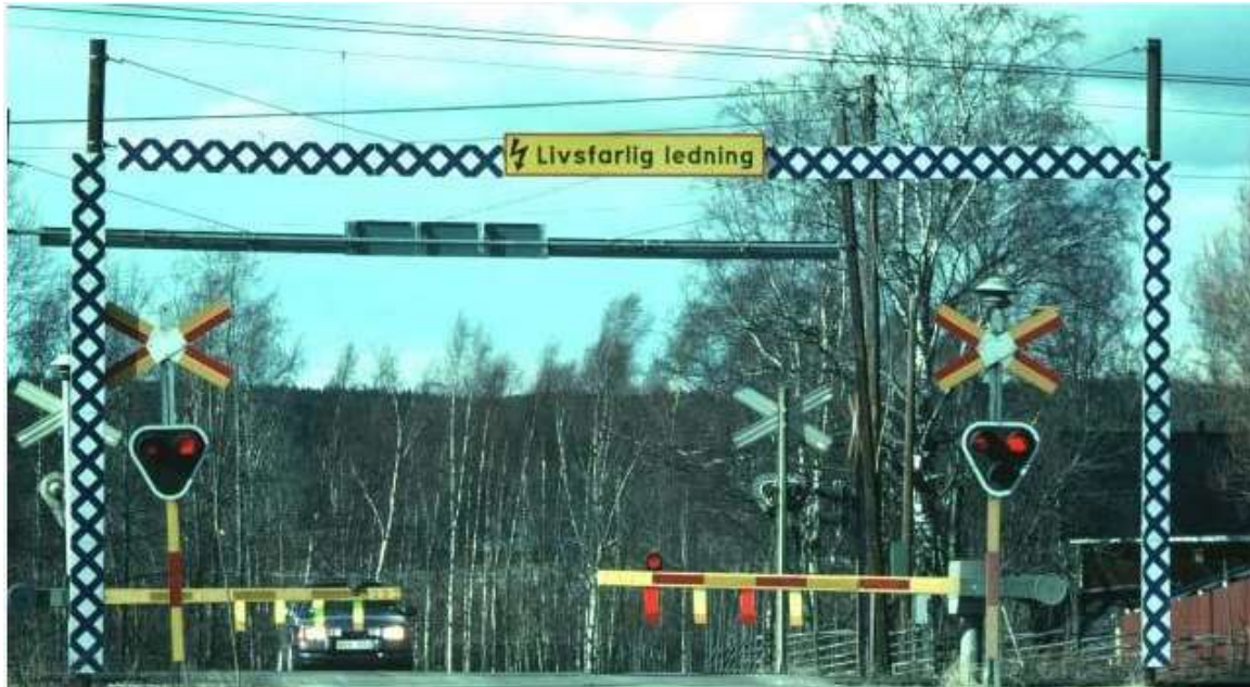
Figur 5.1-2. Ungefärlig utformning av elskyddsportal.
