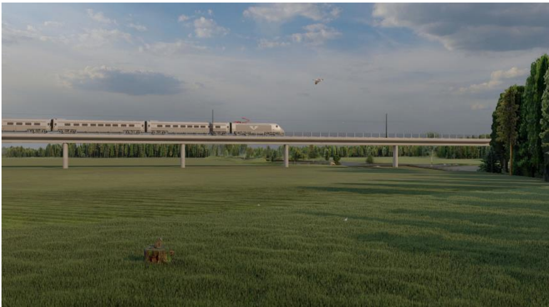
Figur 25. Vy från jordbruksmarkens nordvästra kant. Passage över Rickleån syns till höger (Trafikverket, 2020f).
