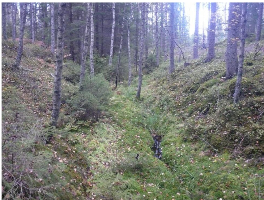
Figur 23. Dike mot Sågabäcken på delsträcka 5.
