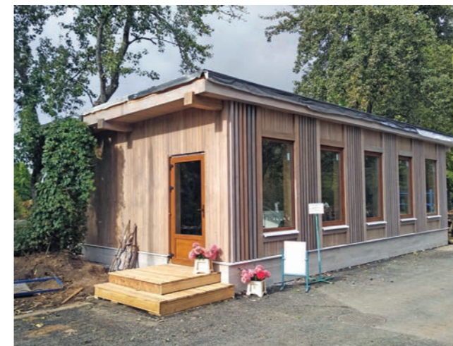
Павильон "Лекторий", середина сентября 2019 г. Кажется, что уже почти всё, но все основные работы впереди!
