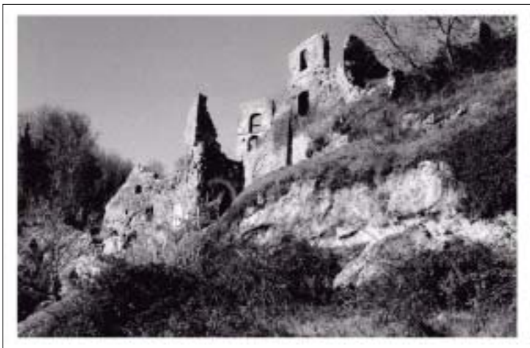
[29] Monterano: porta Cretella o Gradella, durante i lavori di restauro.
