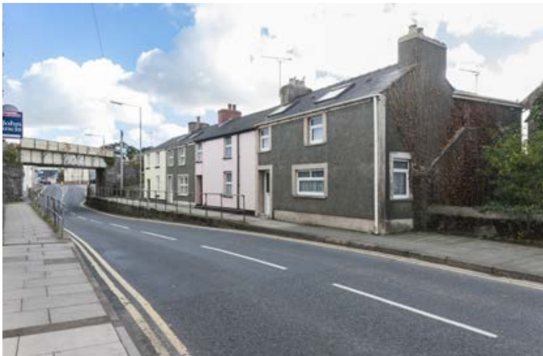
3-9 Station Road, i ochr y dref o'r rheilffordd (Haulfrait y Goron: CBHC).
