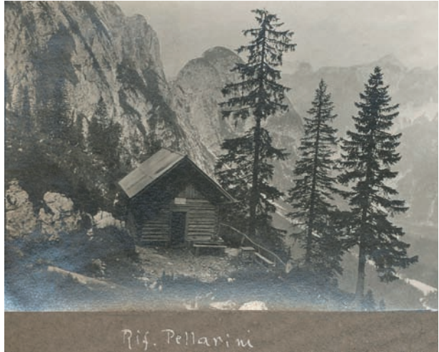
La costruzione del rifugio Pellarini, un chiodo fisso di Dougan.
