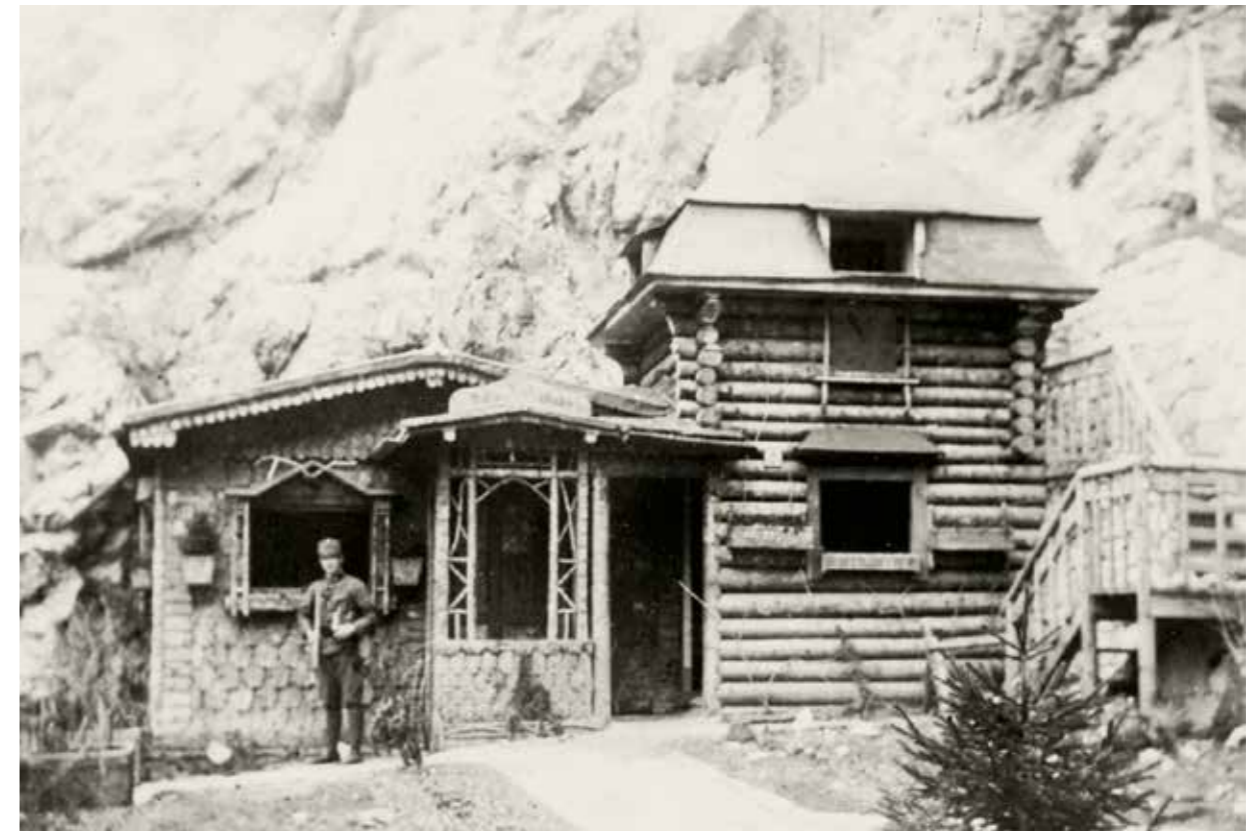
Fig. 36. Baraccamenti austriaci sulla linea difensiva di Bombaschgraben (Pontafel): Villa Gaby - Comando di settore e centrale telefonica (archivio Museo Etnografico del Palazzo Veneziano - Malborghetto).
