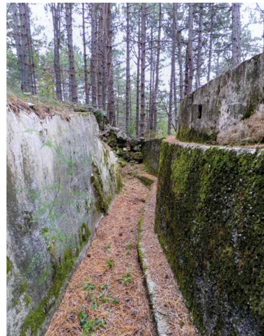
Fig. 3. Monfalcone - quota 85: tratto della Trincea Sant'Elia, dedicata all'architetto futurista caduto nei pressi il 10 ottobre 1916. Trincea di prima linea italiana realizzata dopo la conquista della quota avvenuta con la Sesta battaglia dell'Isonzo (archivio Silvo Stok).
