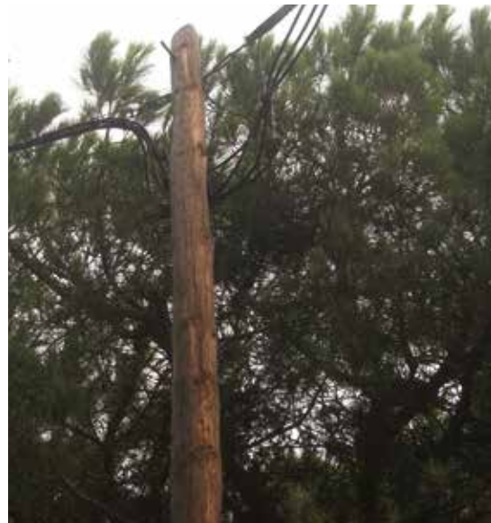
Suport amb cable trenat de baixa tensió. (Fotografia: D. Guinart)
