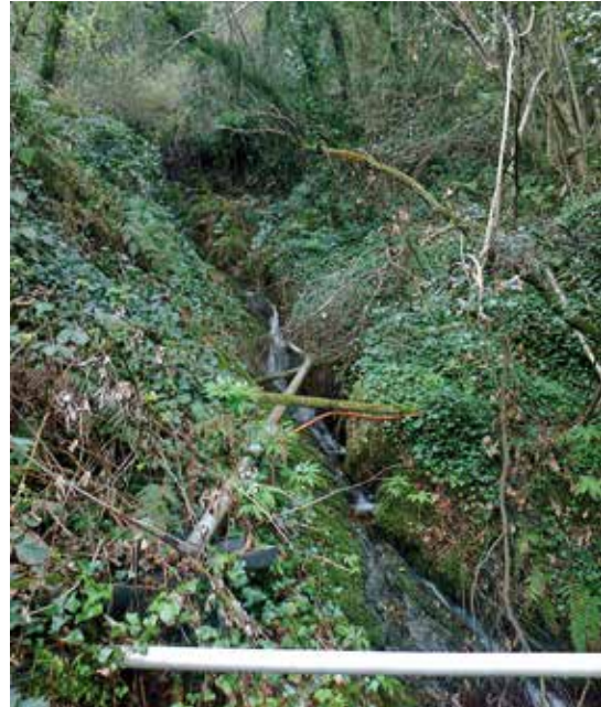
Captació d'aigües amb canonada de PVD, d'un torrent del Montseny, per a ús domèstic. (Fotografia: D. Guinart)
