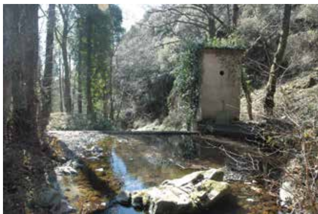
Presca en un torrent per captar aigua. (Fotografia: D. Guinart)
