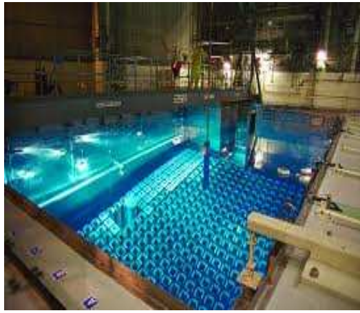
Fig. 25.- Pileta de almacenamiento del combustible usado
