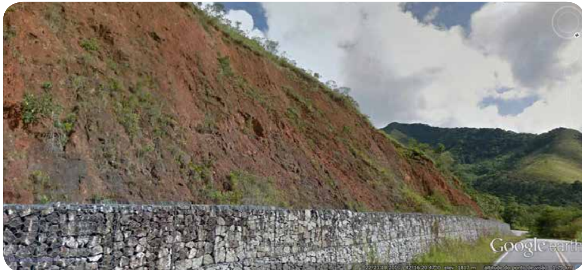
Exemplo de contenção de talude com uso de gabião, às margens da RJ 142. Fonte: Google street view
