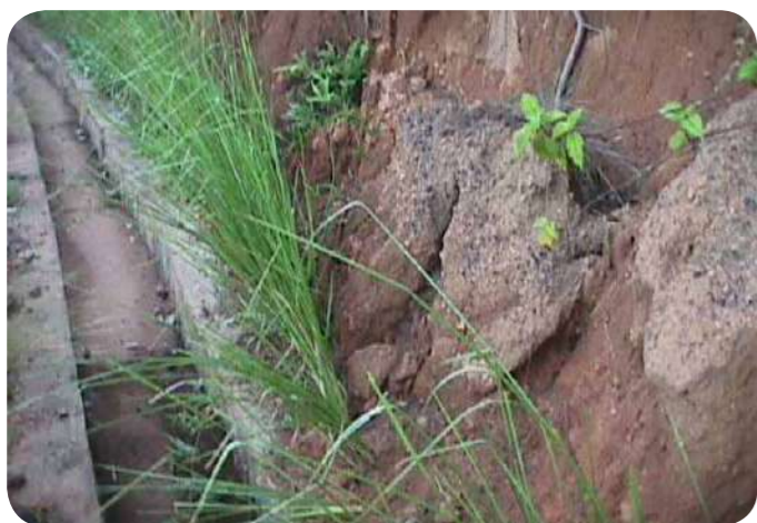
Barreiras de proteção com capim-vetiver.
