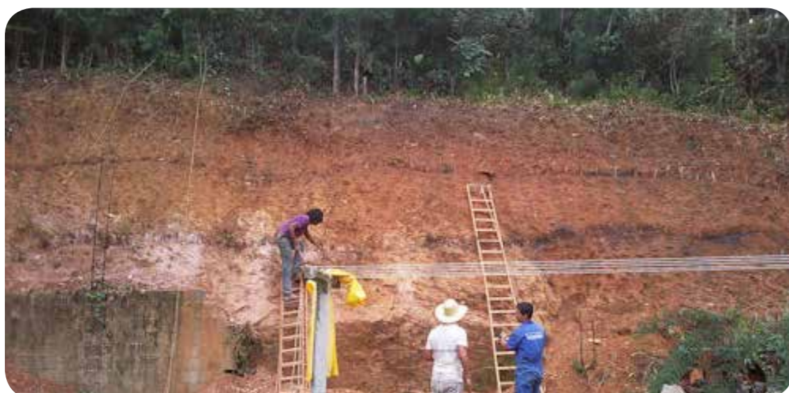
Exemplo de aplicação do capim-vetiver para contenção/revegetação de talude. Fonte: http://deflor.com.br
