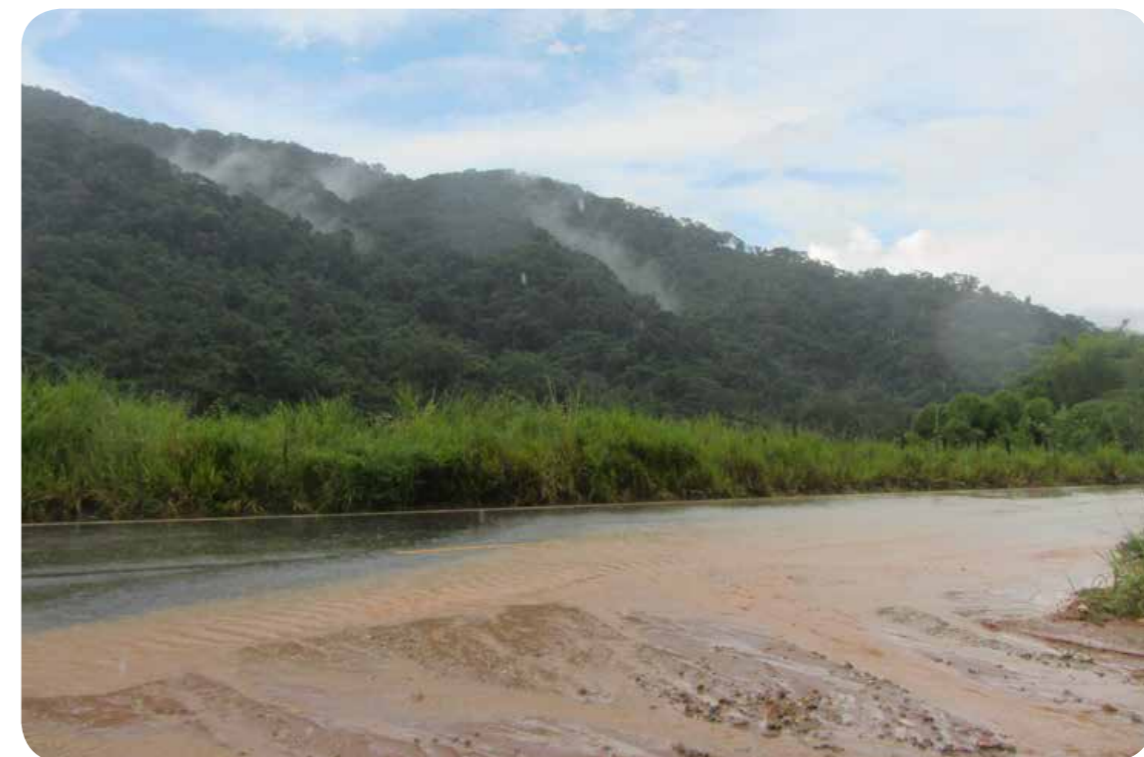
Drenagem inadequada, gerando deposição de sedimentos na RJ 142.
