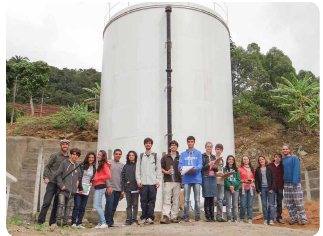
Reservatório de armazenamento de água tratada da ETA da Tapera, em São Pedro da Serra, atividade de educação ambiental do Programa Águas para o Futuro.
