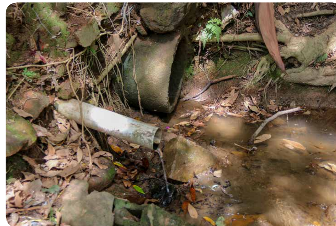
Esgoto doméstico conectado à rede de drenagem pluvial, rio São Pedro da Serra.
