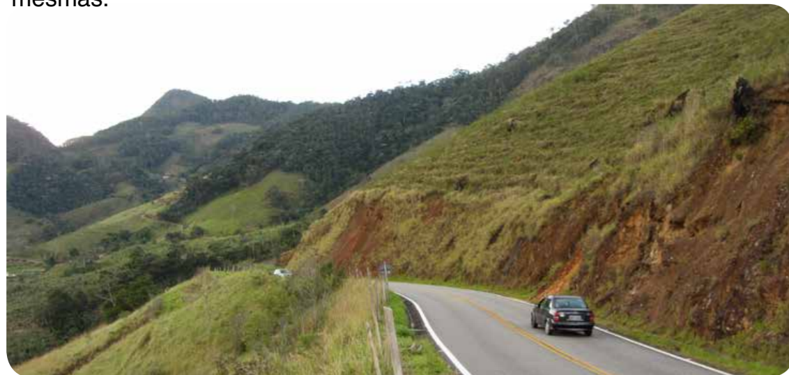
Trecho da RJ-142- predominantemente em corte.
