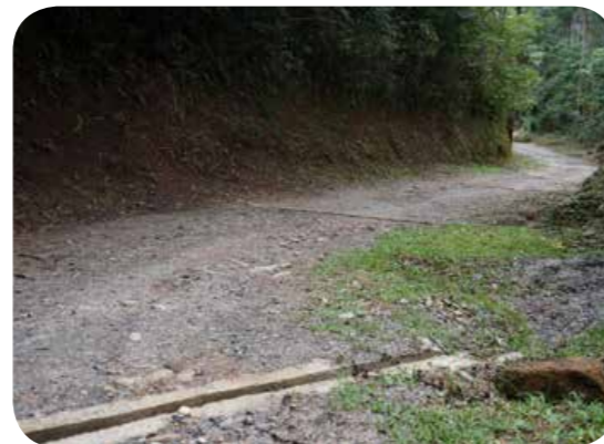
Trecho de estrada vicinal revitalizada pelos moradores.
