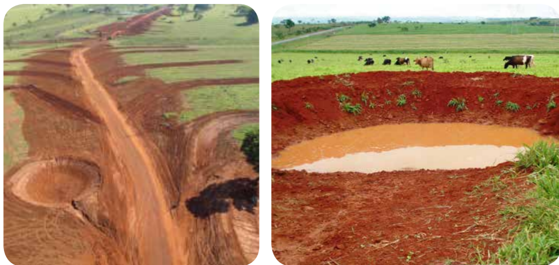
Exemplos de bacias de infiltração (barraginhas) realizadas ao longo de estradas vicinais.
