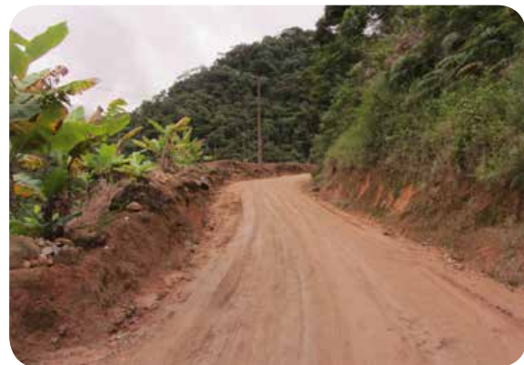
Trecho de estrada vicinal sem pavimentação.
