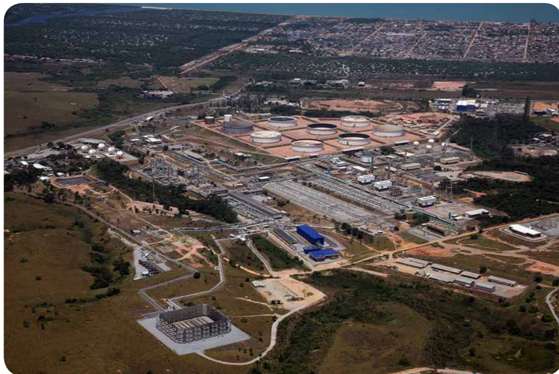
Fotografia aérea do terminal Cabiúnas.
