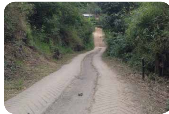
Trecho de estrada vicinal com rampa de concreto viabilizada por moradores.
