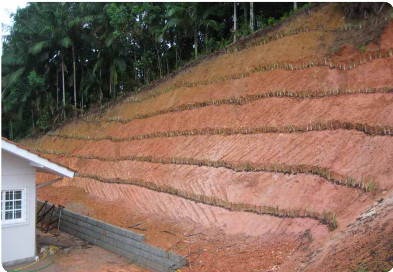
Exemplos da produção do capim-vetiver e sua utilização na estabilização de cortes. Fonte: http://www.jefersonvieira.com.br
