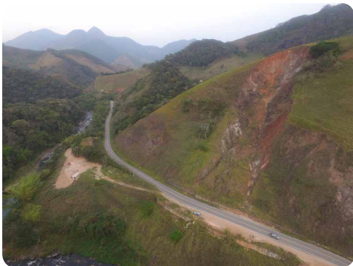
Voçoroca na estrada Serramar (RJ 142).
