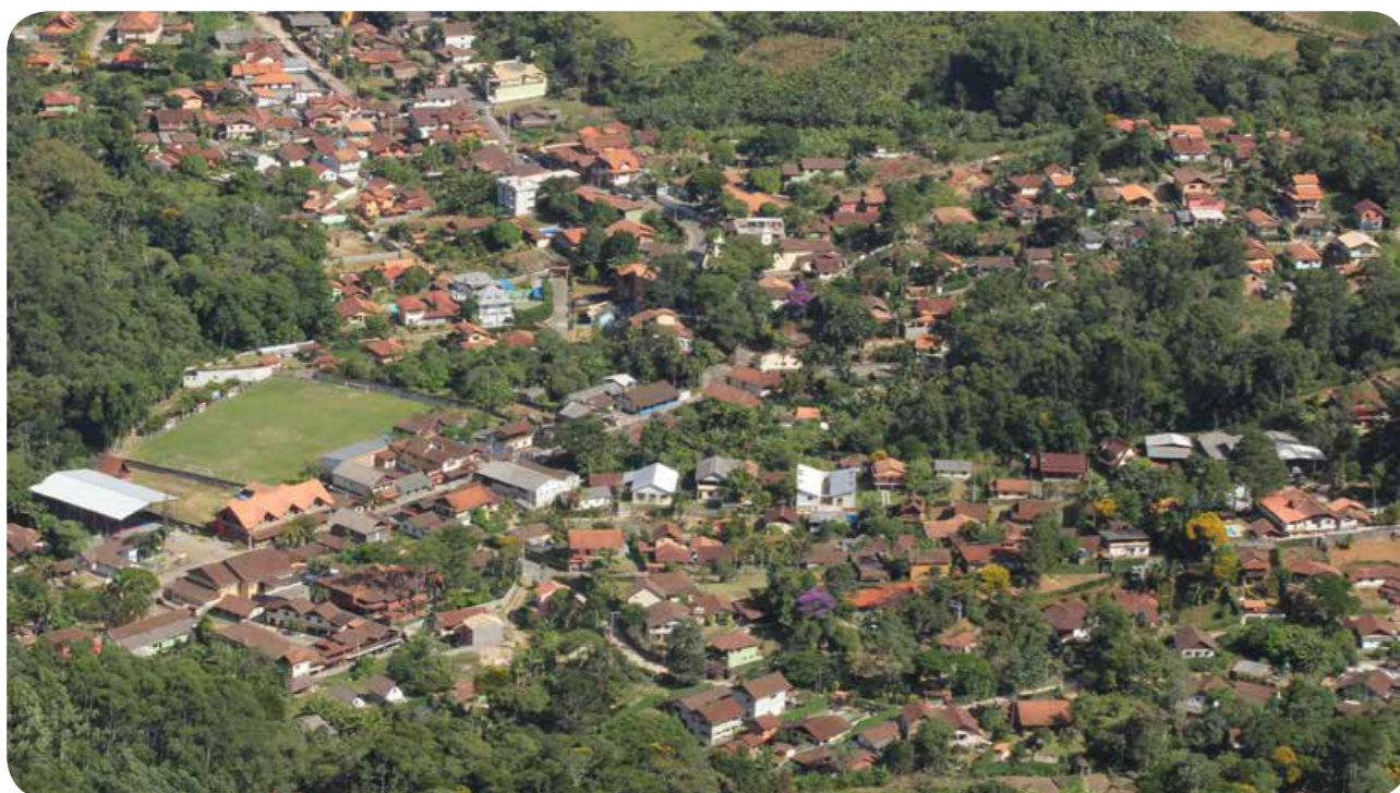
Vista aérea da área urbana de São Pedro da Serra. Foto: Pedro Kiua - Acervo Águas para o Futuro
