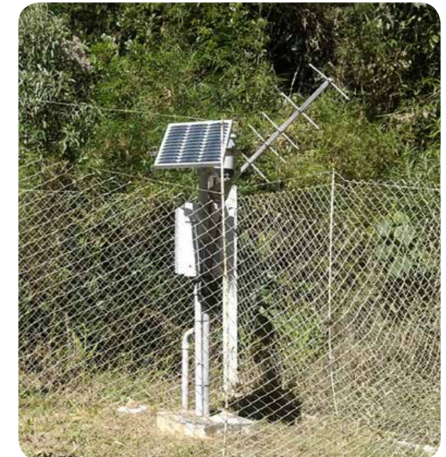
Estação meteorológica automática em Macaé de Cima. Foto: Diego Meyer
