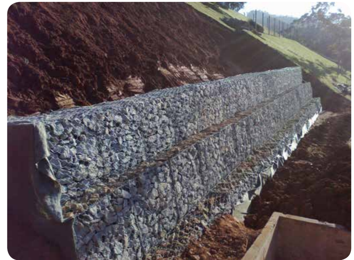
Exemplo de contenção de talude com uso de gabião. Fonte: www.polipav.com.br
