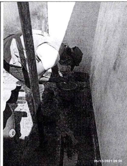
Figure 4. Prueba de bombeo
