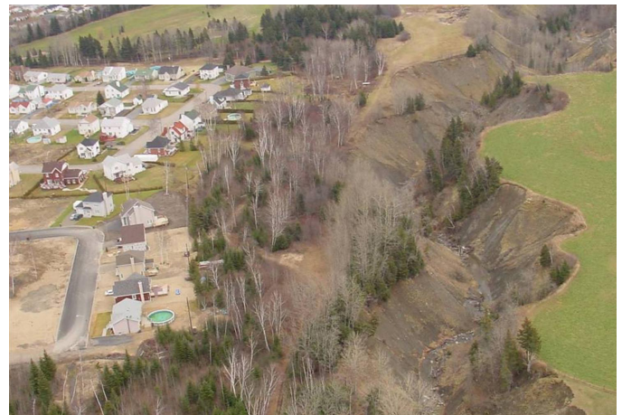
Figure 2 | Exemple de plaine argileuse érodée par un cours d'eau
