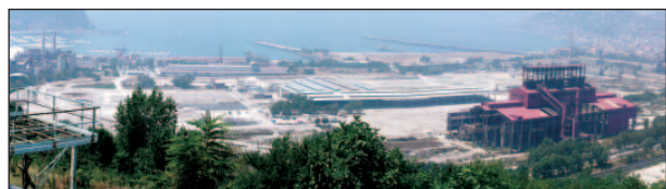
Veduta d'insieme del sito dell'ex Italsider
