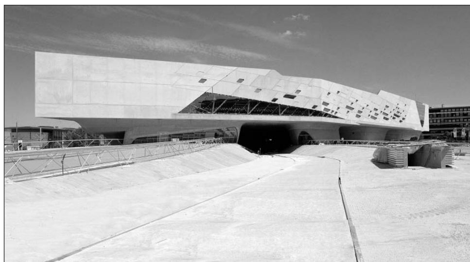
Esterno da sud-ovest (foto di Klemens Ortmeier) e, in alto, interno (foto di Richard Bryant) del Phaeno Science Center
