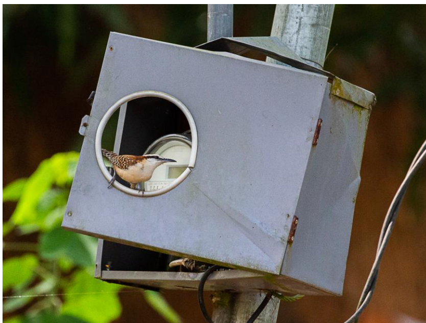
Rufous-backed wren - en stor gärdsmyg, som här bygger bo i ett elskåp. Foto: Jim Sundberg
