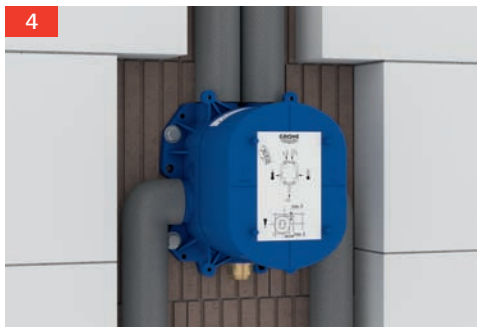
4 Wandaussparung verputzen Markierungen für die richtige Installationstiefe beachten
