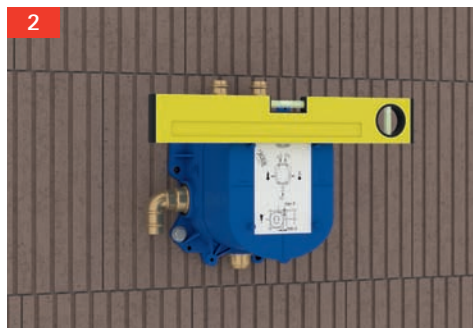
2 Unterputzventil ausrichten Bohrlöcher anzeichnen Löcher bohren und Einbaukasten montieren
