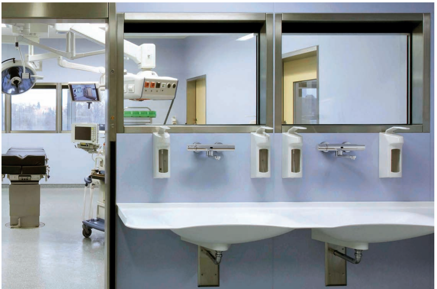
Erfüllt höchste Hygieneanforderungen: die GROHE Eurosmart CE Thermostat-Waschtischbatterie mit Infrarotelektronik Foto © Jochen Stüber, Hamburg
