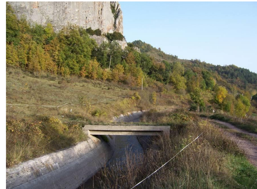
FOTOGRAFÍA 42. Canal afectado por el trazado, en el TM de El Pont de Suert. La nueva carretera cruzará el canal en este punto (PK 113+760 aproximadamente).
