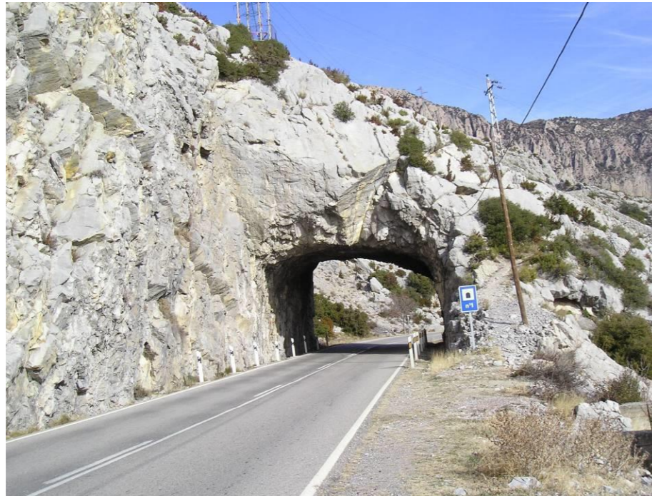
FOTOGRAFÍA 1. Afloramiento de calizas al inicio del proyecto.
