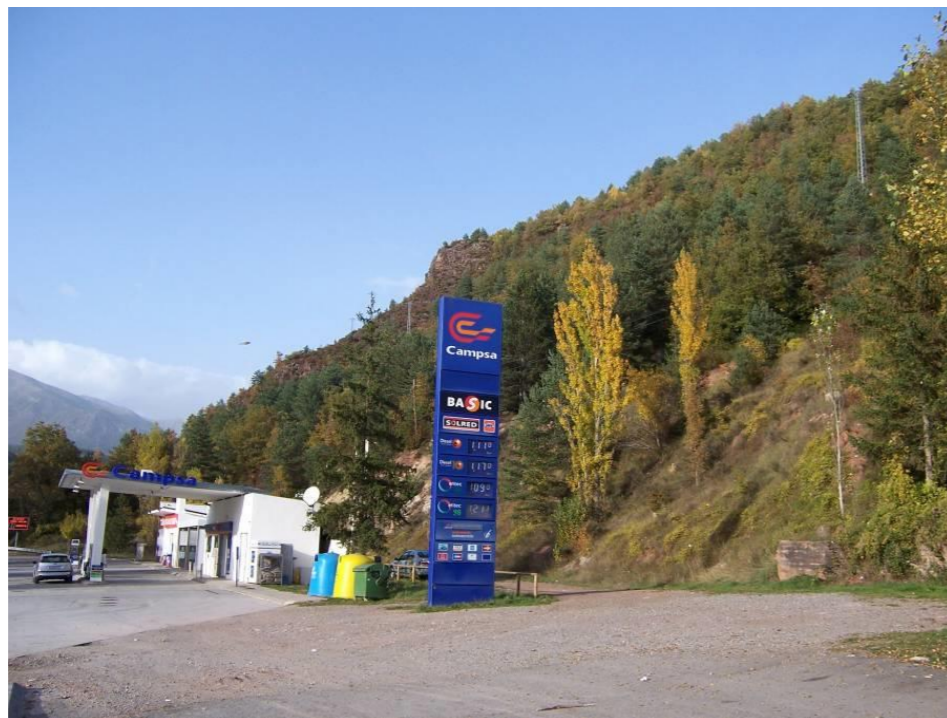
FOTOGRAFÍA 47. Gasolinera situada en las inmediaciones de la traza (PK 114+150), en el TM de Vilaller. En este punto, el trazado de ambas alternativas circula justo por el lado opuesto de la gasolinera (a la izquierda de la fotografía), aprovechando la calzada actual en la alternativa 2 y desplazado ligeramente en las alternativas 1 y 3..
