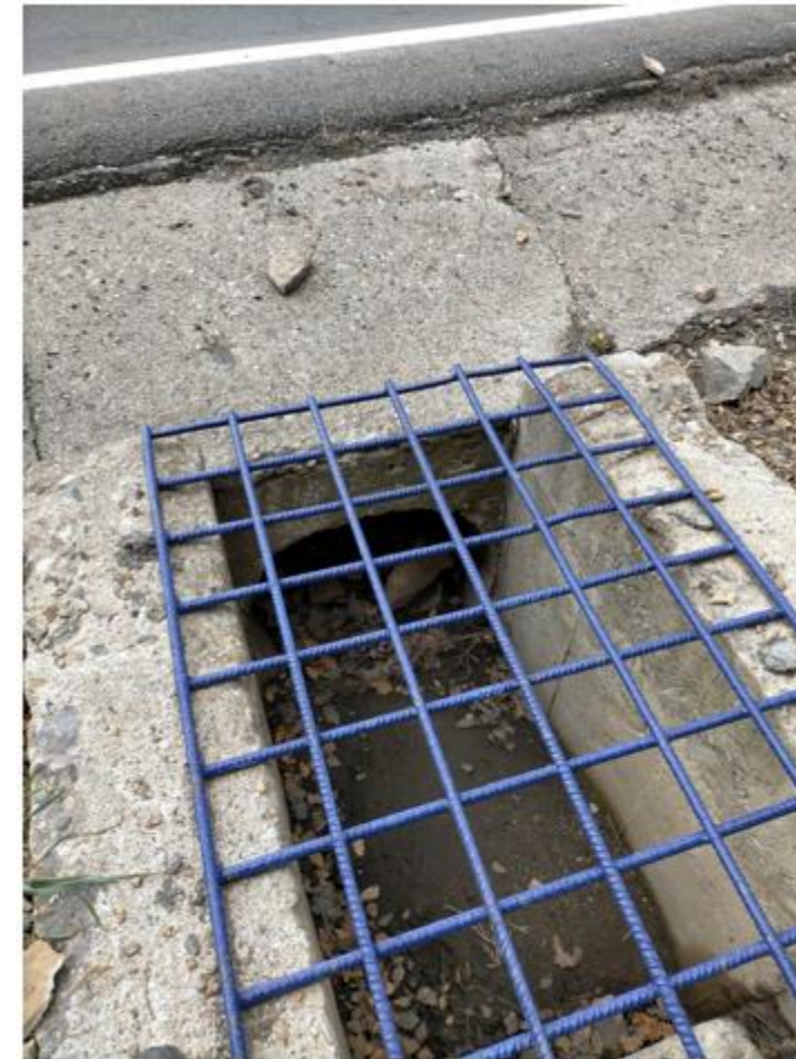
FOTOGRAFÍA 59. Paso de fauna para garduña, gineta y zorro. Constituido por desagües de la carretera lados. Este paso es recurrente a lo largo de la carretera, la mayoría de los cuales se encuentra en buen estado, con capacidad de paso para la fauna prevista. Es un paso de calidad para la fauna, con afectación notable por el proyecto, puesto que es atravesado por los tramos planteados.
