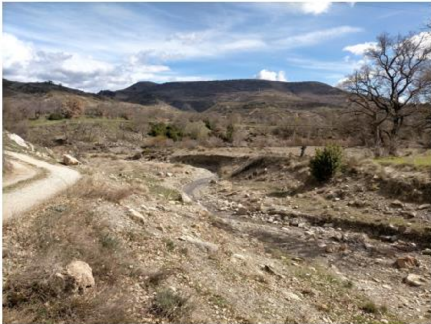
FOTOGRAFÍA 58. Paso de fauna para garduña, tejón, jabalí y zorro. Constituido por el paso de la carretera por encima de una torrentera ancha que conecta ambos lados. Es un paso de calidad para la fauna, con afectación notable por el proyecto, puesto que es atravesado por los tramos planteados.
