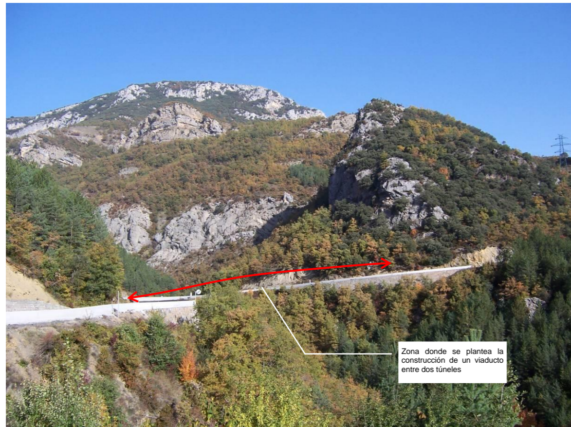
FOTOGRAFÍA 37. Carretera N-230 en el entorno del embalse de Escales. En la zona indicada y para las tres alternativas planteadas, se propone la construcción de un viaducto para salvar el Barranco de les Casetes, entre los túneles propuestos para salvar el Serrat de Sant Salvador (Cerro de San Salvador) y la Collada de Cellers (Collado de Cellers), alrededor del PK 102+250 (alt 1 y 3), 103+400 (Alt2)
