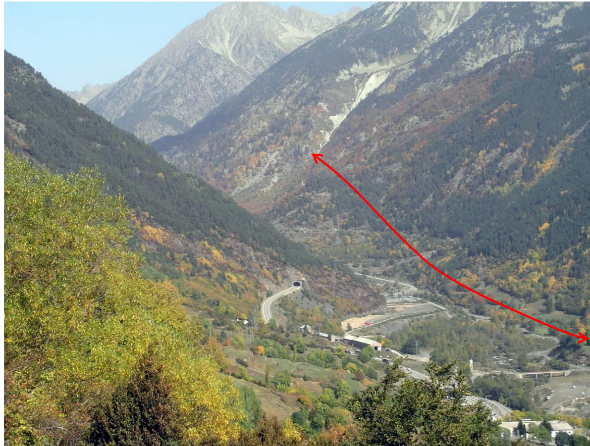
FOTOGRAFÍA 41. Vista de la actual N-230 desde la carretera de Llauset (en el núcleo urbano de Aneto) hacia el norte, en dirección a la salida del túnel de Lladó (aproximadamente en el PK 144,5 de la vía actual). El nuevo trazado elimina la curva inferior introduciéndose en la vertiente de la ladera occidental que se observa en primer término de la fotografía para dirigirse al citado túnel.
