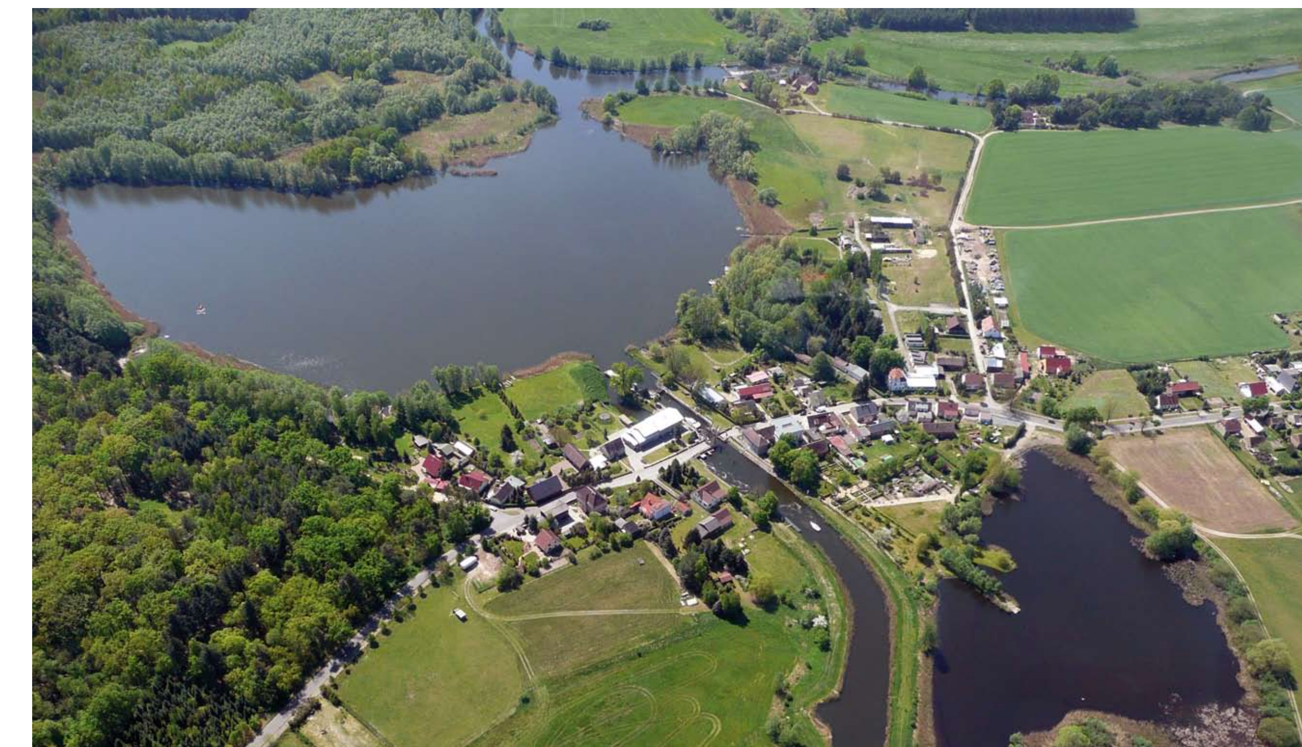
Schleuse und Pumpwerk Neuhaus, Neuhauser Speisekanal und Wergensee, Photo Ulrich Gerwin 2008
