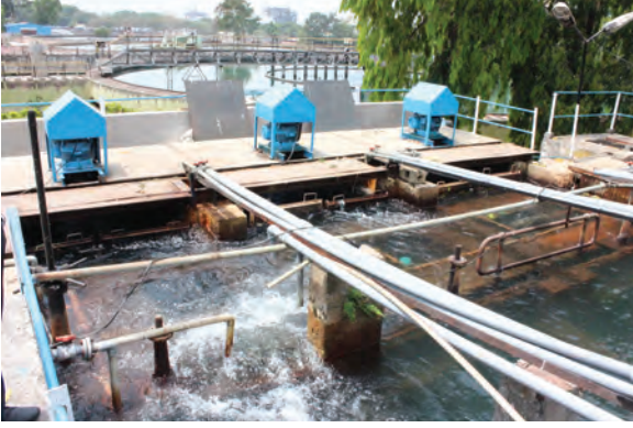
ઑક્સિજનીકરણ - પંપની મદદથી પાણીમાં હવા રમતી રખાય છે. તેથી પાણીમાં હવાનો ઑક્સિજન ભળે છે.
