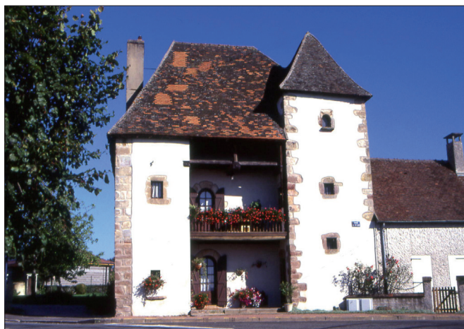
Fig. 3 - La maison dite «Le Pavillon»
