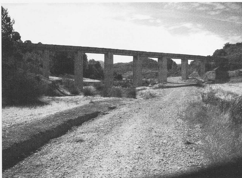
Acueducto en Cabanillas construido en 1948
