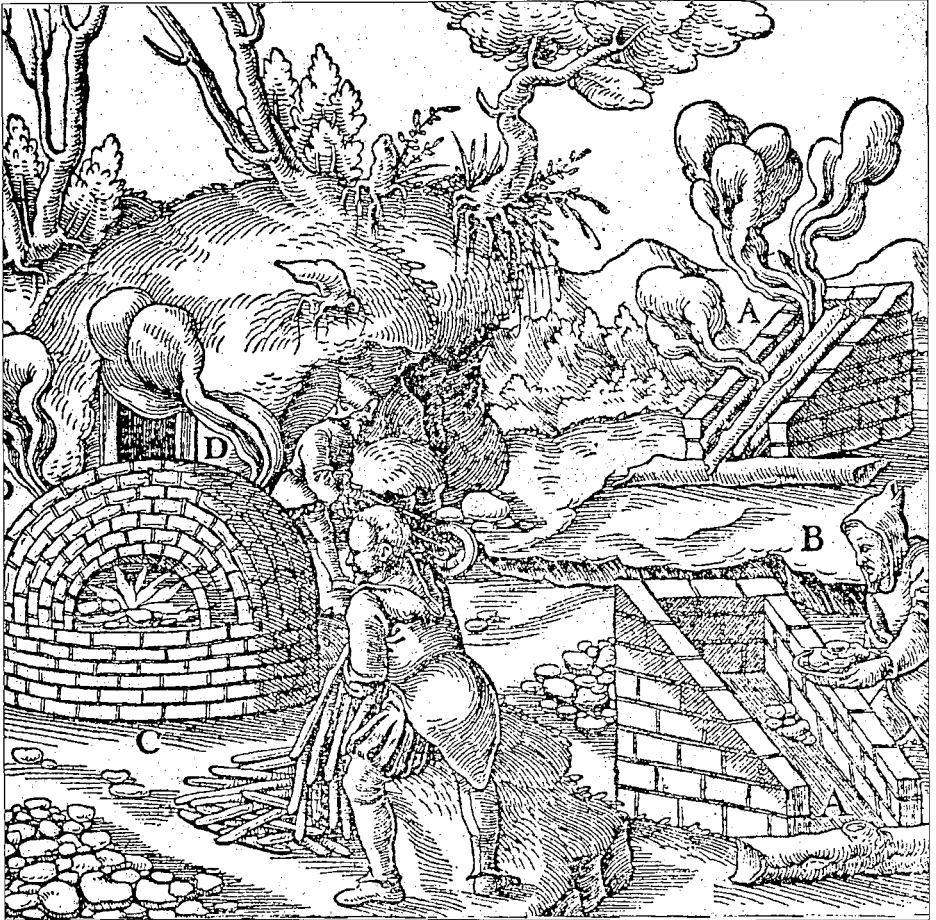
A: Pira ardiendo compuesta de mineral de plomo con madera colocada encima de ella. B. Obreros echando mineral en otra pira. C: Horno en forma de hogar. D: Abertura de salida de humo
