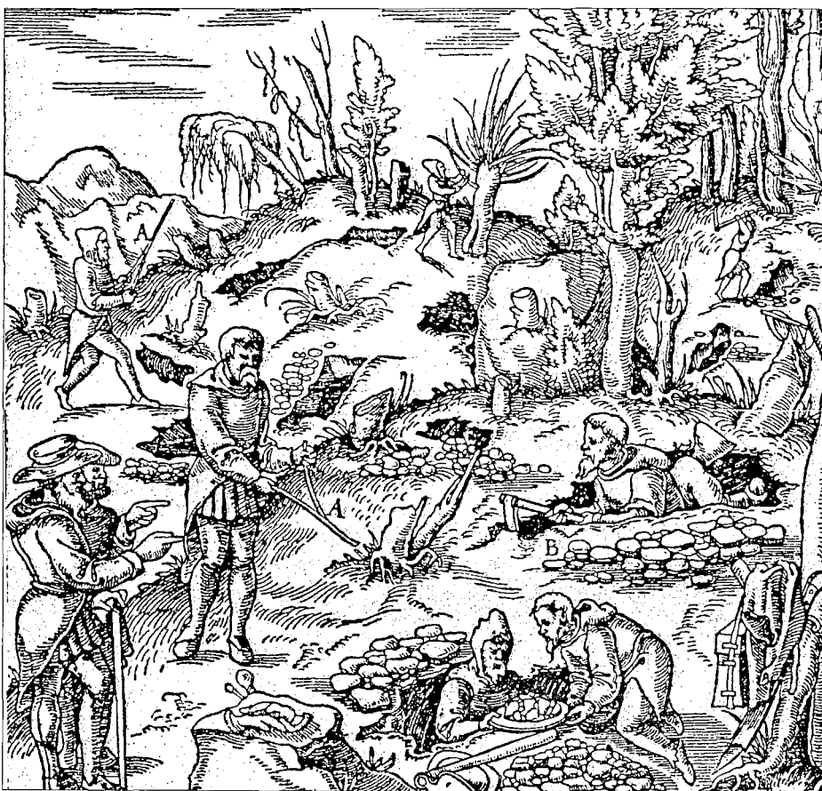
Búsqueda del zahorí y calicata de prospección
