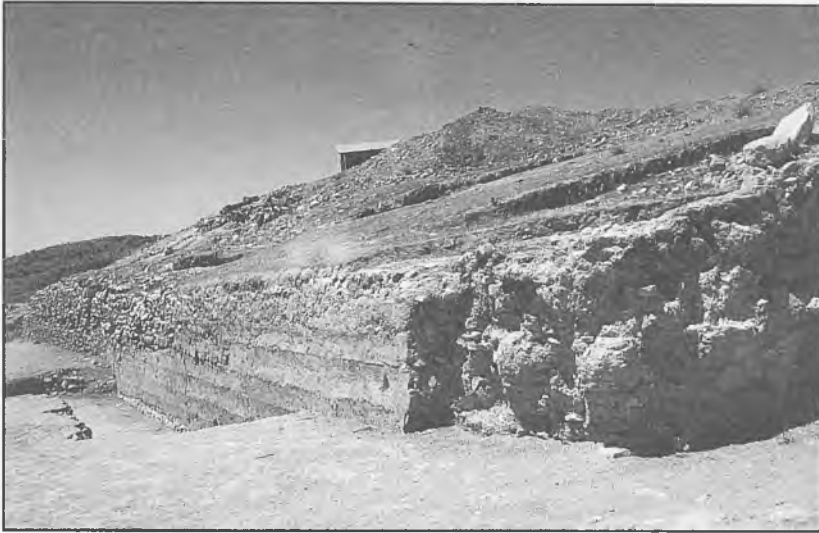
Fig. 4. Muralla de Alarcos. Esquina sin sillares y marcas del encofrado
