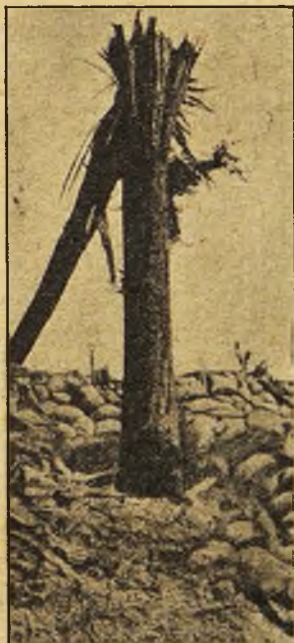
Estado en que quedó un árbol unto a una trinchera francesa
