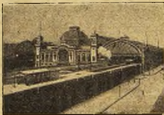
Estación de Dresde
