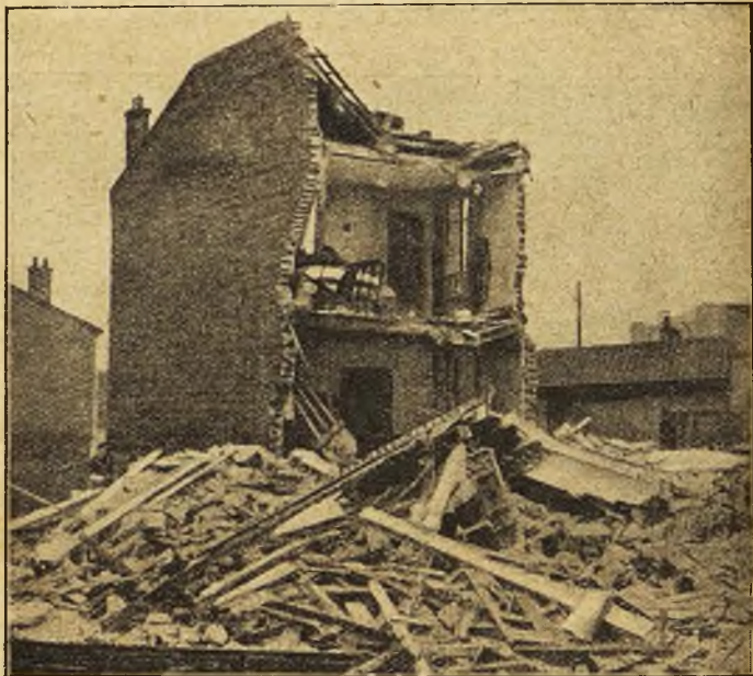
Efectos causados por la bomba de un zeppelin
