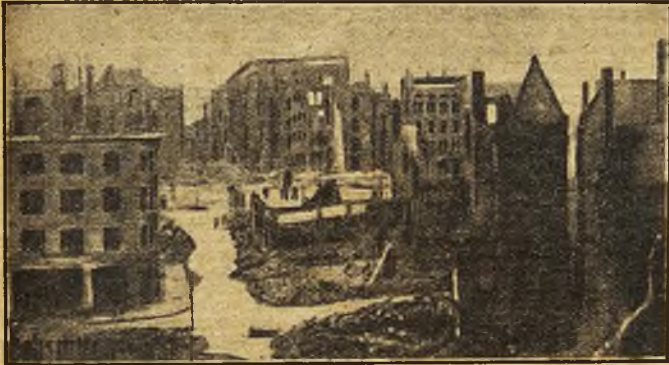
Bergen.—Todo un barrio destruido por un incendio
