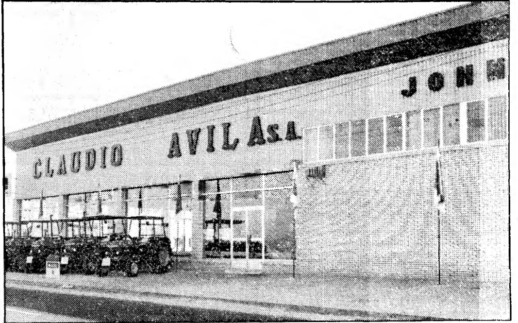
Locales de la firma Claudio Avila, S. A., situados en el polígono industrial de Toledo
