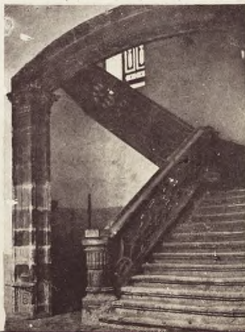
Escalera principal del edificio, verdadera joya de arquitectura.
