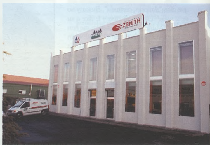
Vista general de las instalaciones
