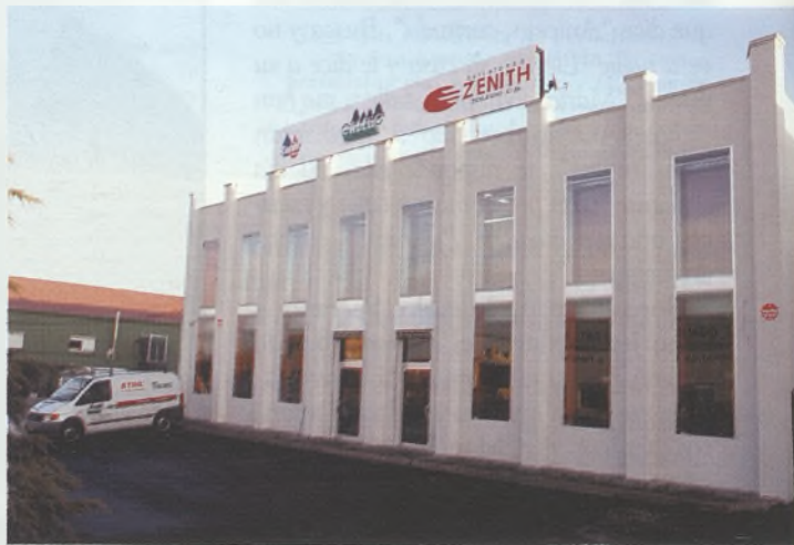
Vista general de las instalaciones
