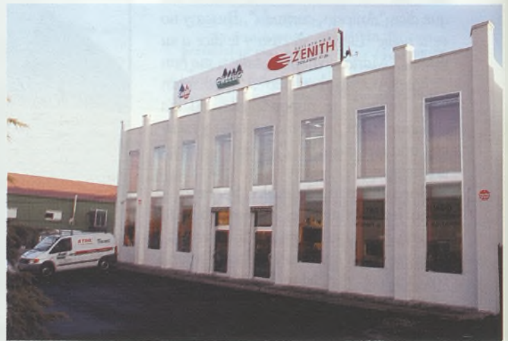
Vista general de las instalaciones
