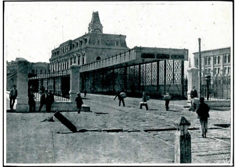
Estación de Bellavista totalmente incendiada
