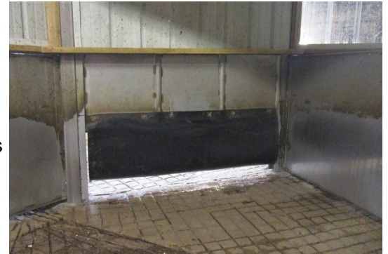
Puerta de goma con solapa; Las puertas deslizantes verticales construidas con una cortina flexible hecha de cintas transportadoras no dañarán a los cerdos si se cierran accidentalmente sobre ellos. Observe cómo el marco que se desliza en el riel se atornilla por encima de la cortina.
