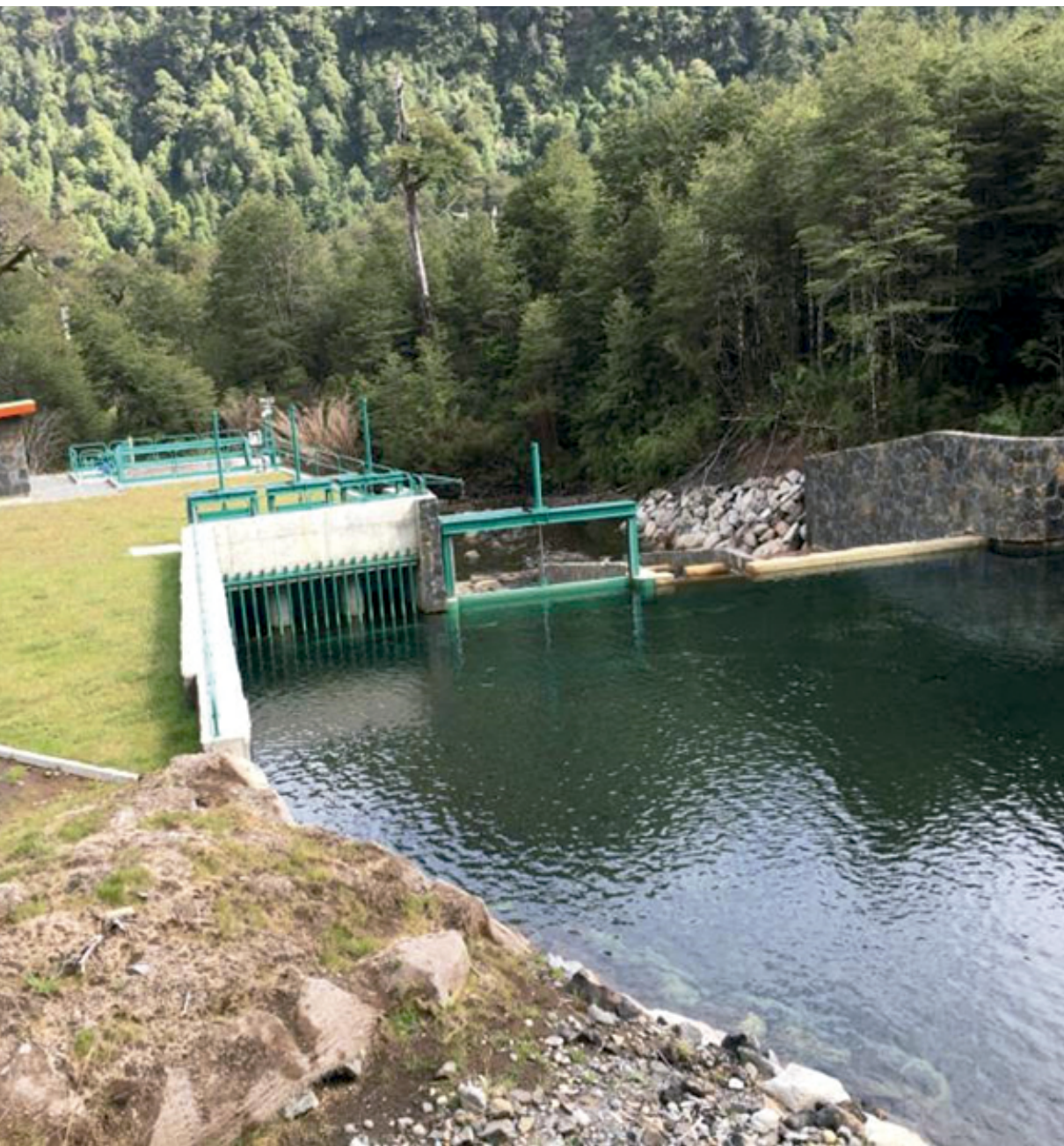
Fig. 20. Bocatoma de central de paso Río Bonito, dentro del Parque Nacional Puyehue. Foto año 2020.
