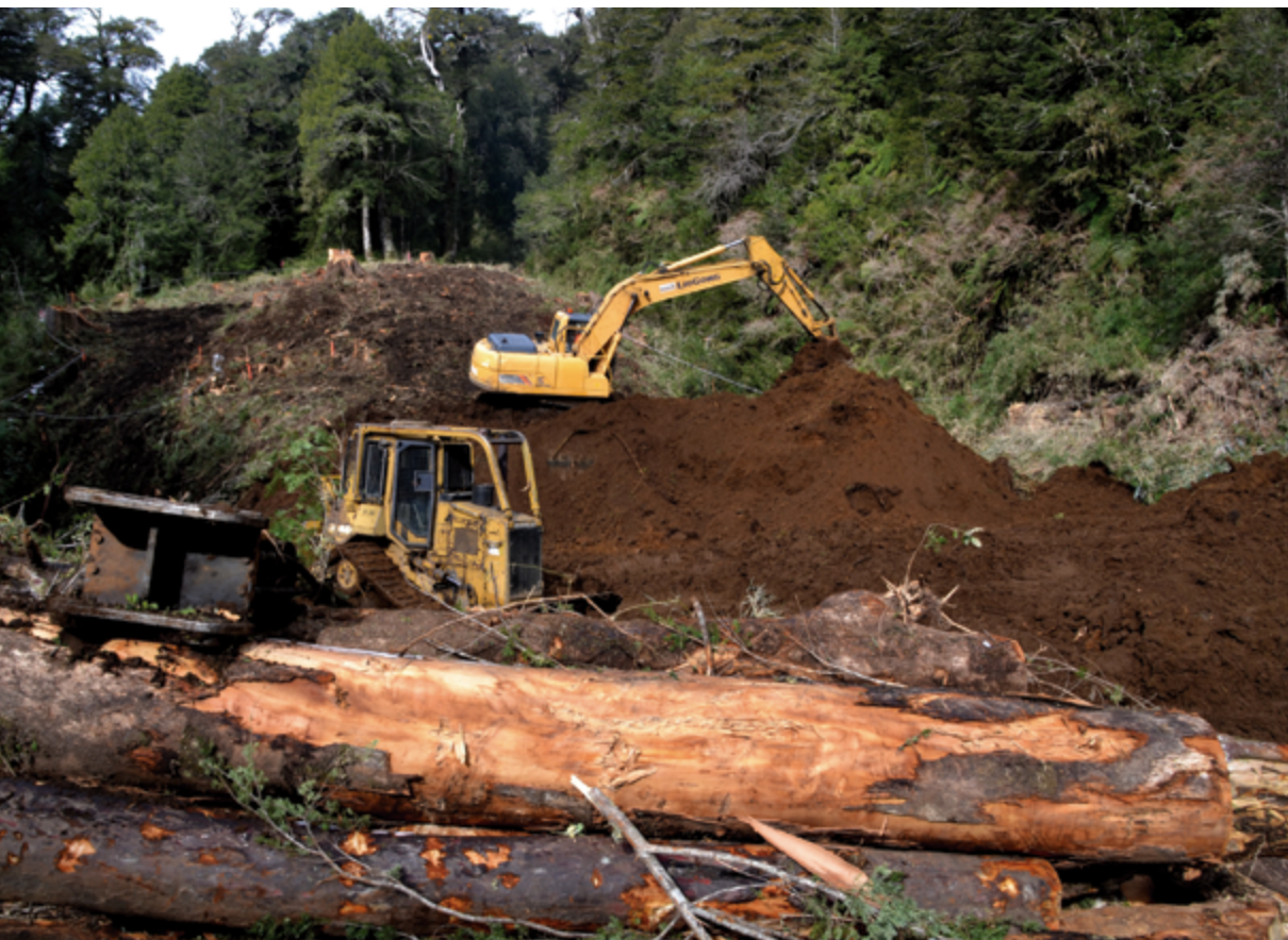
Fig. 19. Maquinaria trabajando en la construcción de central de paso Palmar Correntoso, Parque Nacional Puyehue.
