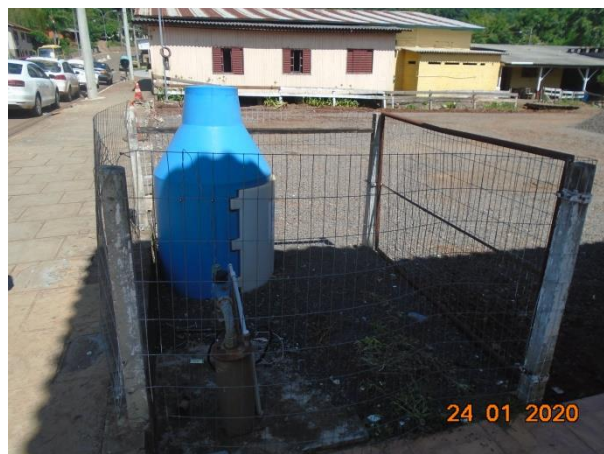
Figura 16 e 17 - Poço tubular 01 em frente ao prédio da Prefeitura Municipal de Carlos Gomes, que abastece a área urbana, Linha São Valentin e Linha Lajeado Polônia - com portaria de outorga
