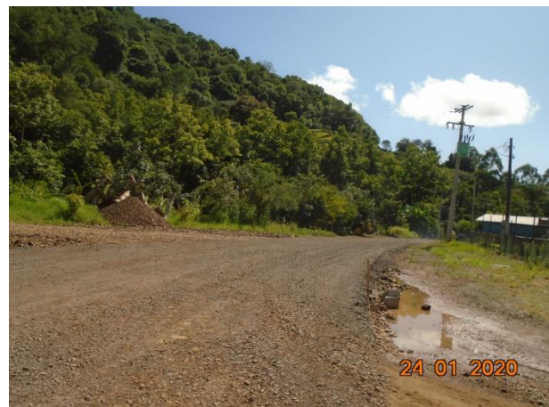
Figura 99 - Rua a receber pavimentação asfáltica em obras, com rede de drenagem pluvial em processo de execução.
