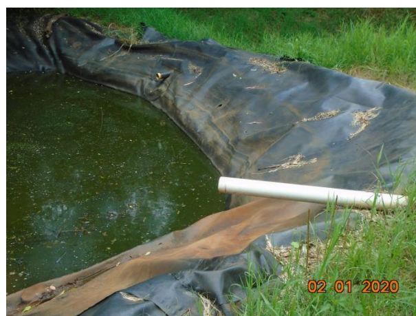
Figura 84 - Drenagem do percolado gerado na célula do aterro.
