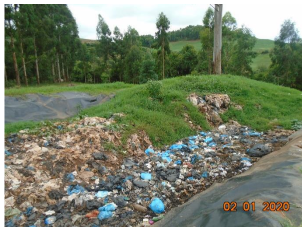
Figura 82 - Em detalhe, resíduos sobre a manta de impermeabilização da célula.
