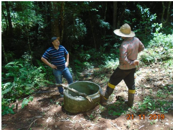
Figura 40 - Vista geral do poço escavado, localizado entre um fragmento de vegetação nativa e silvicultura de eucaliptos
