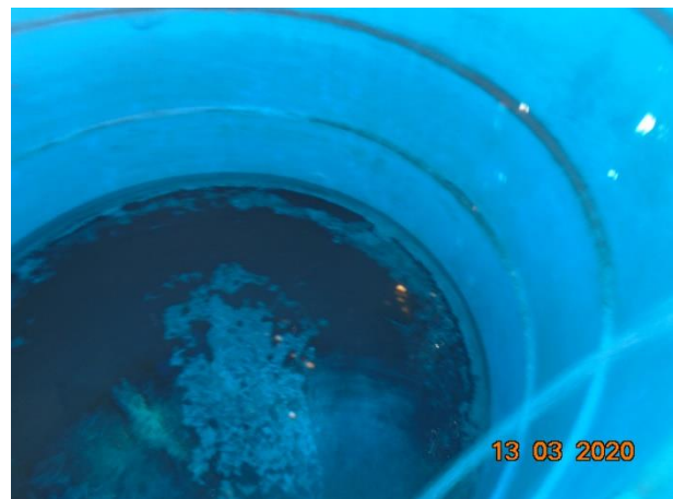
Figura 66 - Interior do reservatório de água
