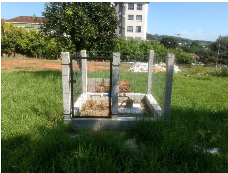
Figura 68 - Modelo de poço tubular com estrutura física adequada
