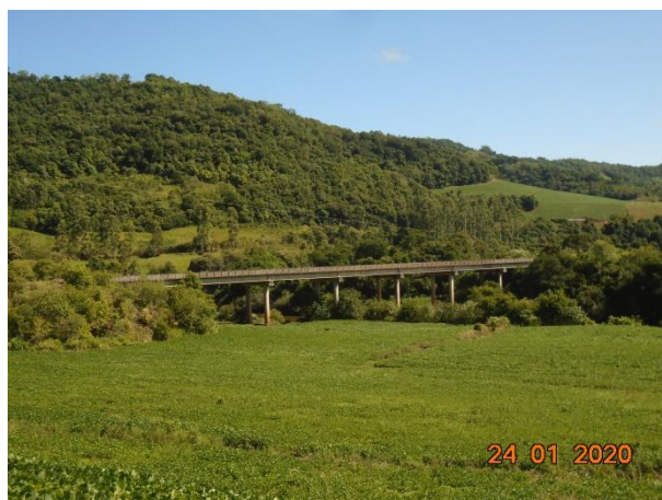
Figura 5 - Ponte construída sobre o Rio Apuaê-Inhandava como principal acesso aos municípios da Microrregião de Sananduva
