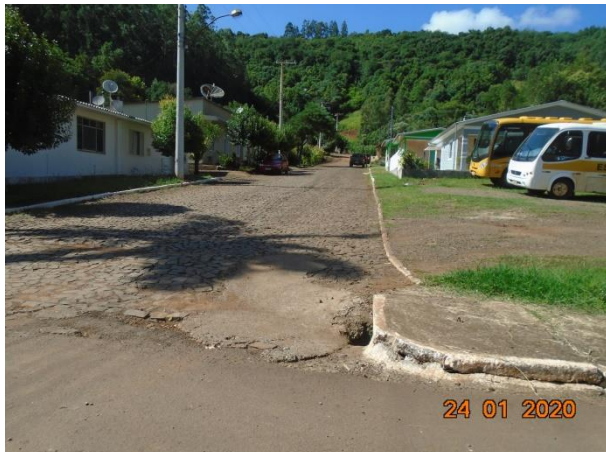
Figura 96 - Bueiro para coleta de águas pluviais em área urbana, onde há infraestrutura de rua implantada.
