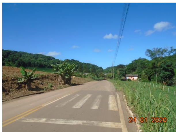
Figura 4 - Vista geral de uma das principais vias de acesso ao município. Área urbanizada asfaltada e acesso aos municípios vizinhos por estrada de terra
