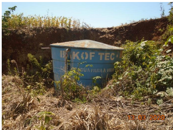
Figura 65 - Caixa d'água coberta ao lado de estrada e lavoura
