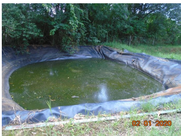
Figura 83 - Vista geral da lagoa de acúmulo de percolado.
