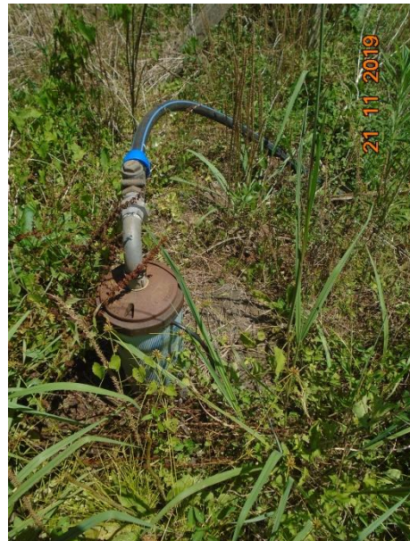
Figura 32 - Em detalhe vista do poço tubular – com outorga
