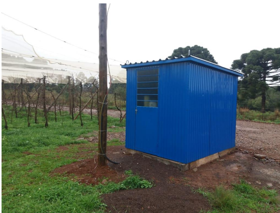
Figura 69 - Modelo de cercamento de proteção para poços que também pode ser utilizado
