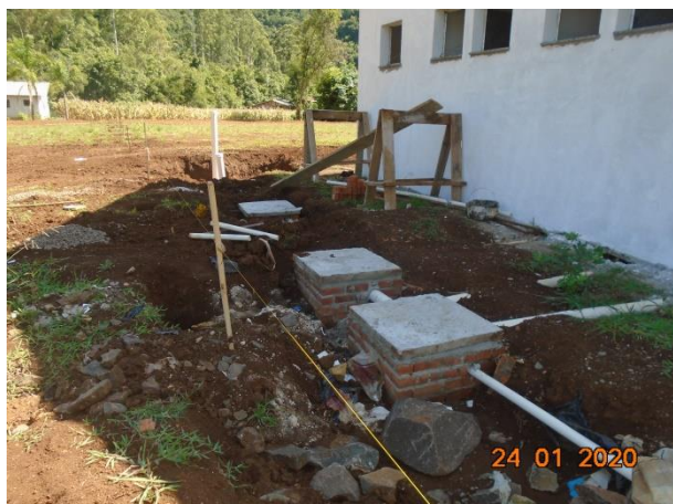
Figura 77 - Edificação nova, com implantação adequada do sistema individual de tratamento de esgoto.
