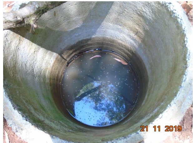
Figura 41 - Poço escavado onde é obtida água para abastecimento de 7 (sete) famílias
