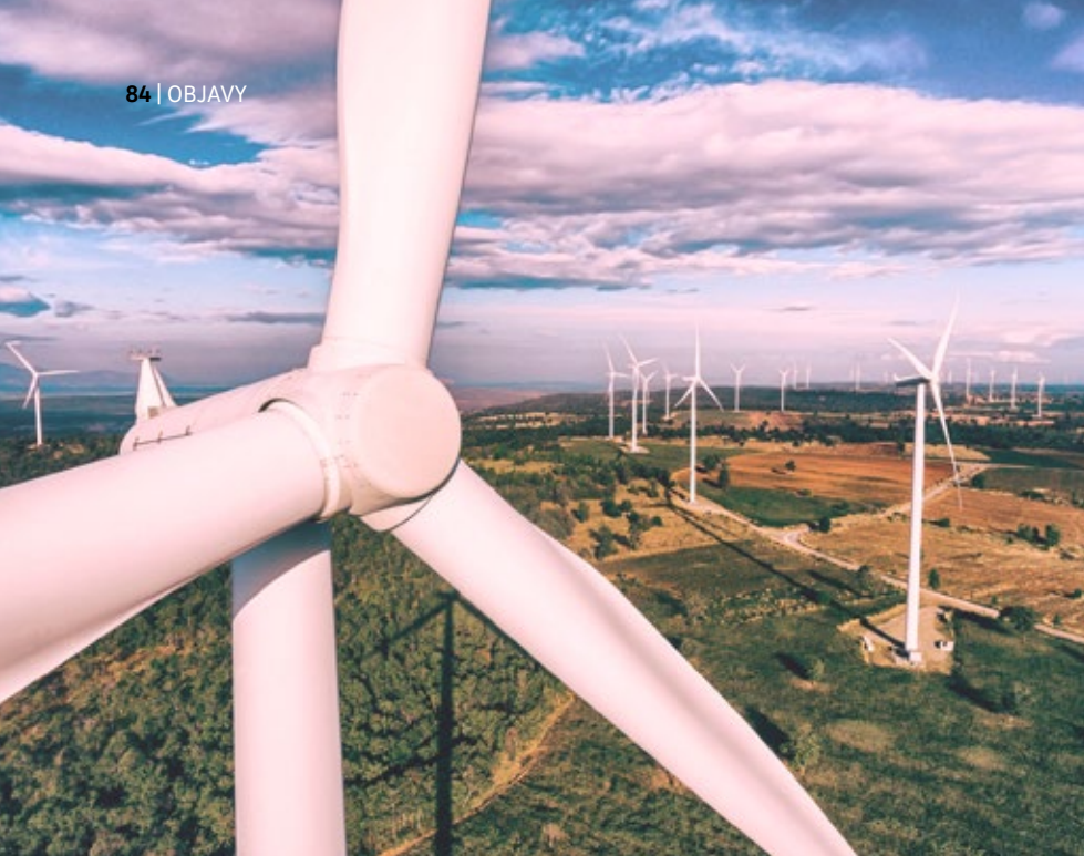
Elektrická energia, ktorú dodáva spoločnosť Elli, pochádza výlučne z obnoviteľných zdrojov
