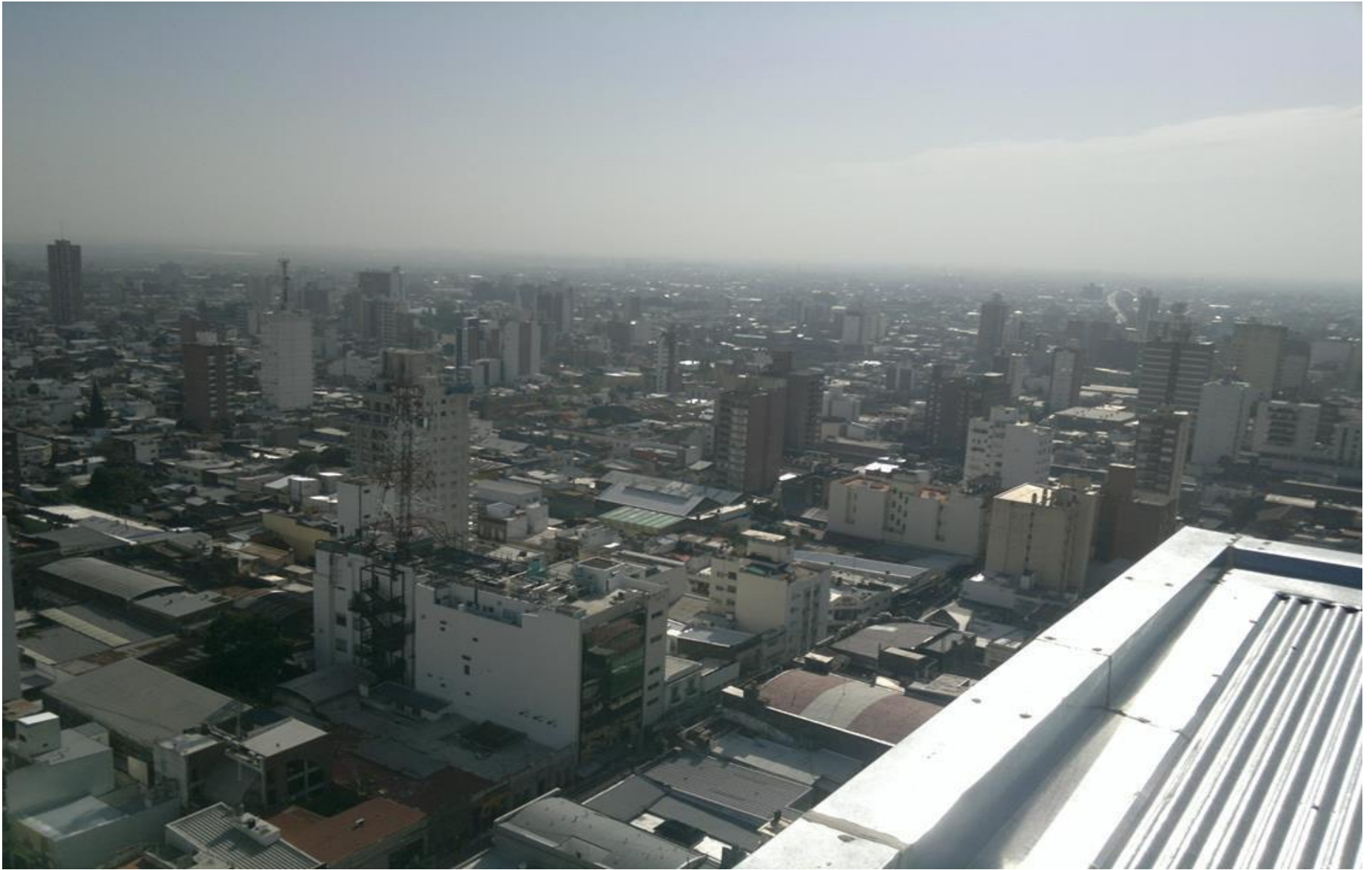
Antena nodo central de Telecom – Santa Fe
