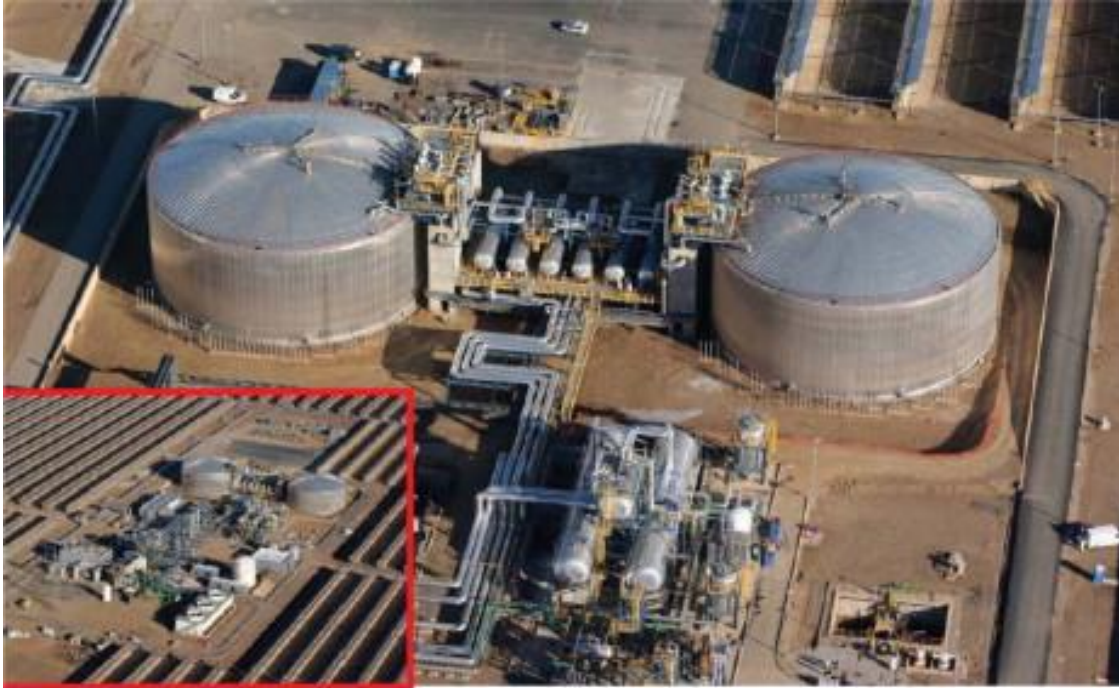
Fig. 19. Almacenamiento térmico de sales fundidas en la planta ANDASOL-1.
