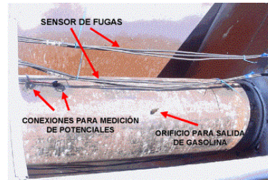
Figura 1.7. Izq. Diagrama del sensor para detectar fugas de hidrocarburos. Der. Sensor para detectar fugas de hidrocarburos instalado a un costado de una tubería.
