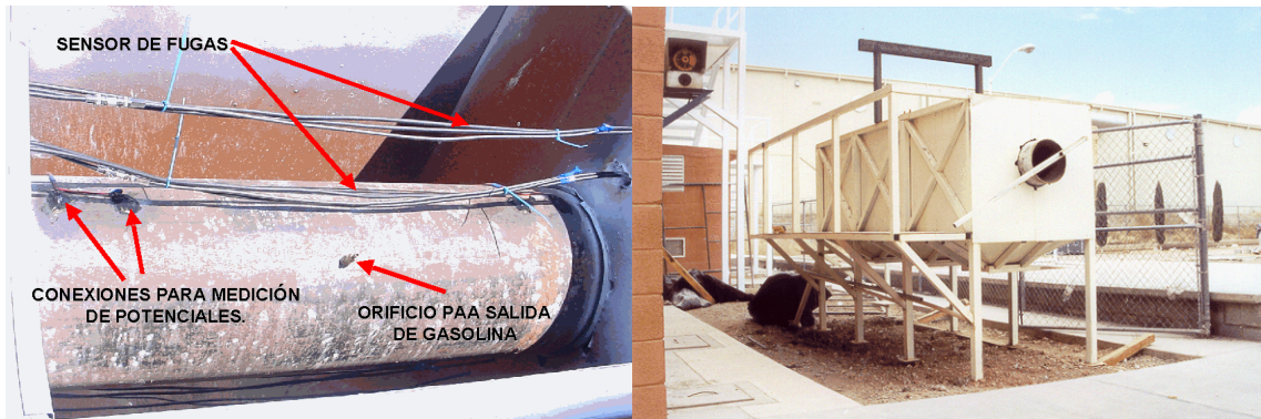
(a) (b) Figura 5.7. (a). En esta fotografía se aprecia el sensor de fugas instalado en el simulador; (b). Vista general del simulador de fugas.
