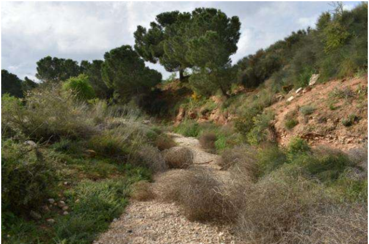
Foto 09: Taludes con moderado riesgo de deslizamientos y desprendimientos
