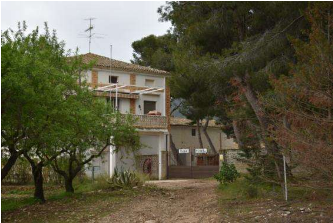
Foto 25: Subunidad Edificaciones. Casa de Peñas
