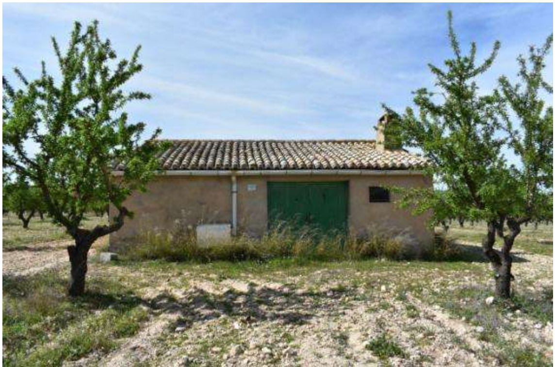
Foto 26: Subunidad Edificaciones. Caseta aislada
