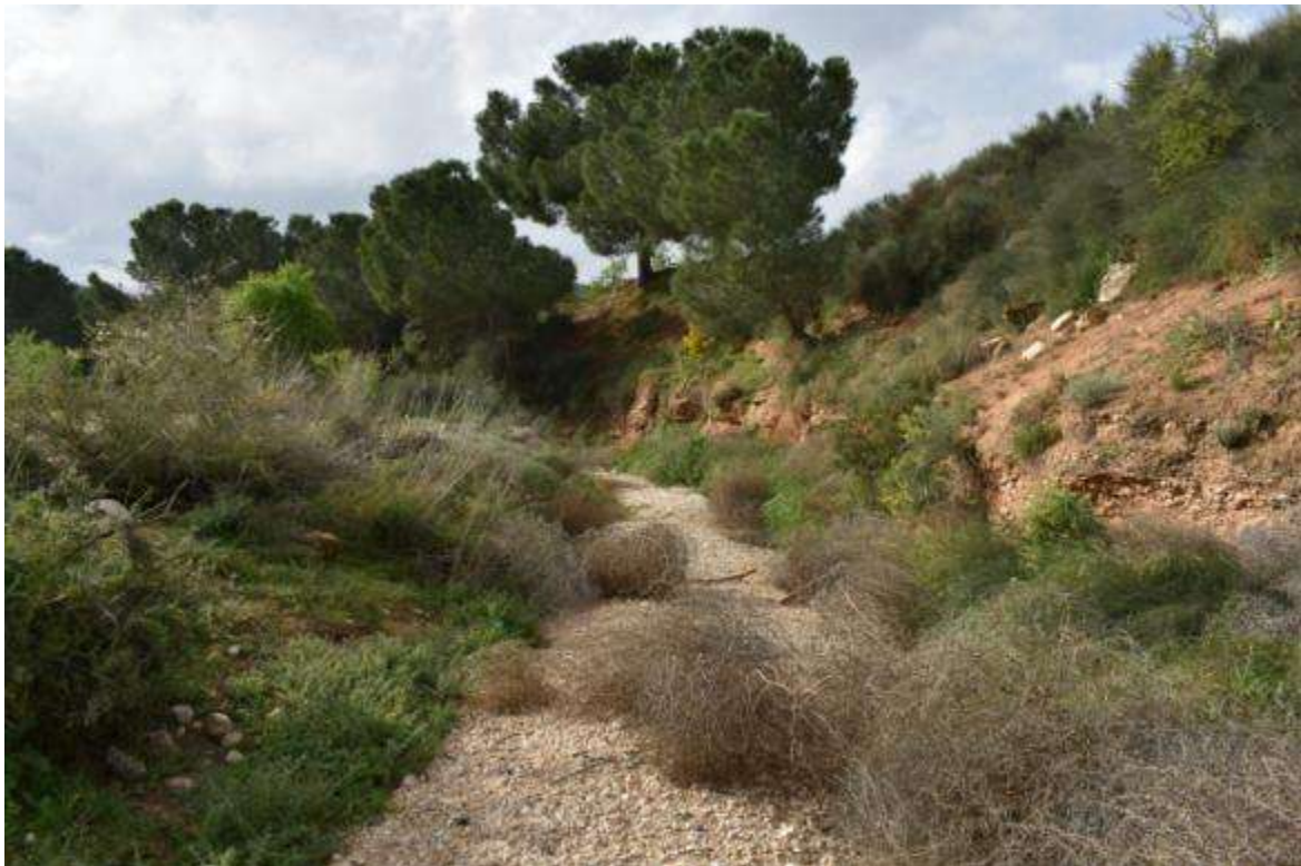
Foto 10. Taludes con moderado riesgo de deslizamientos y desprendimientos
