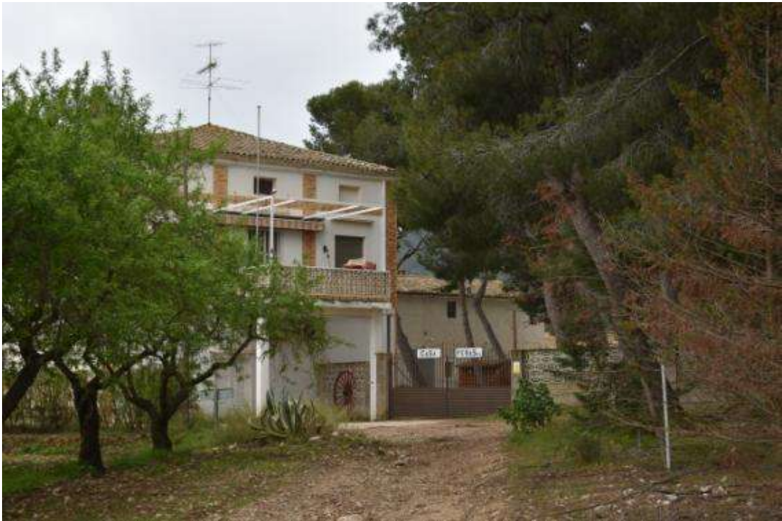
Foto 26: Subunidad Edificaciones. Casa de Peñas
