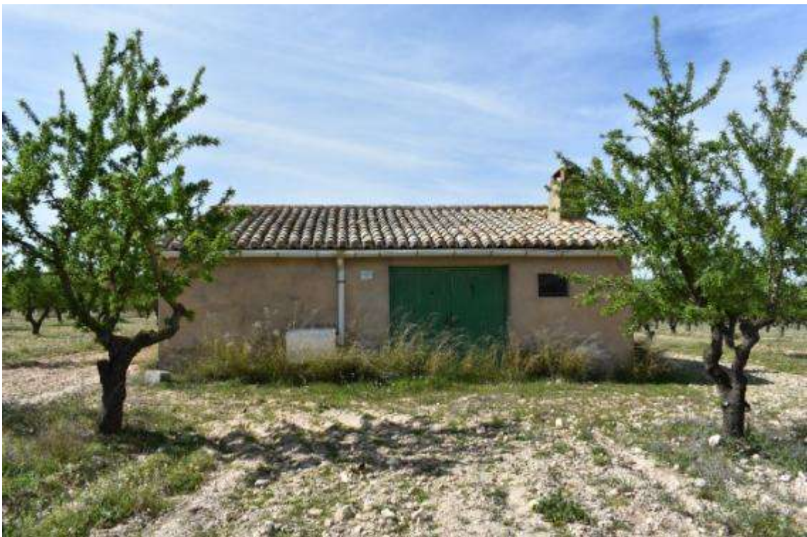
Foto 27: Subunidad Edificaciones. Caseta aislada
