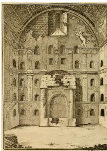
Tav. XXII. Veduta interna di un Sepolcro sotterraneo a Campana, di sopra detto a S. Vito Vue intérieure d'un tombeau souterrain à Campana vis à vis S. Vito
